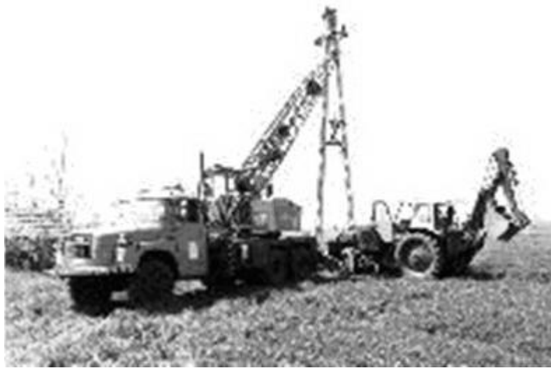
2.1 ábra: Külterületi közép- és nagyfeszültségű hálózat építés a múlt században
