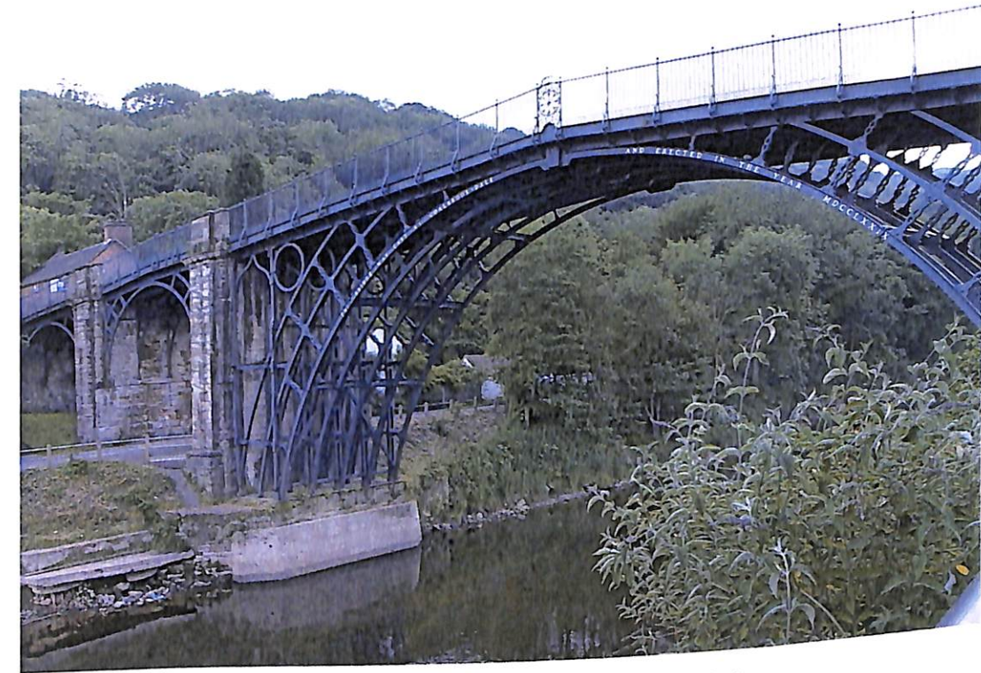
4. kép: Vashíd (Coalbrookdale, Anglia)
