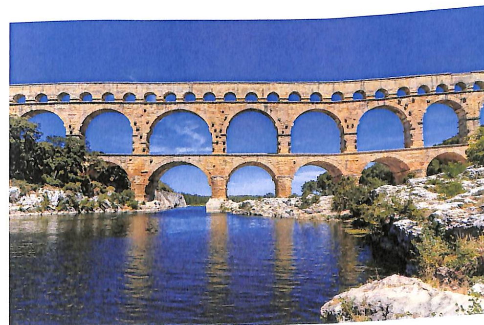
1. kép: Pont du Gard-híd (Nîmes, Franciaország)
