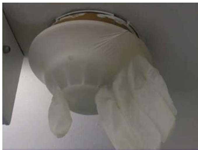
12. kép Gumikesztyűvel letakart tűzjelző
