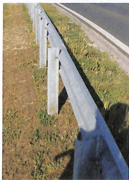
15. kép: Acél szalagkorlát oszlopai
