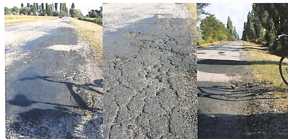
21. kép: Repedések, süllyedések, deformálódások a 6213. számú vegyes használatú úton
