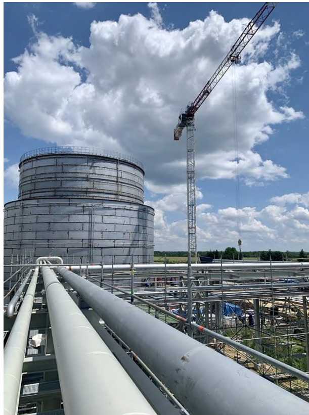
9. ábra Szivattyúállomáson elhelyezett 15.000 m 3 -es szigetelt acél védőgyűrűs tartály Forrás: https://mol.hu/hu/molrol/mediaszoba/7744-9-milliard-forintos-beruhazassal-evi-tobb-mint-15-000-tartalyauto-fuvar-t-ki-a-mol-csurgon
