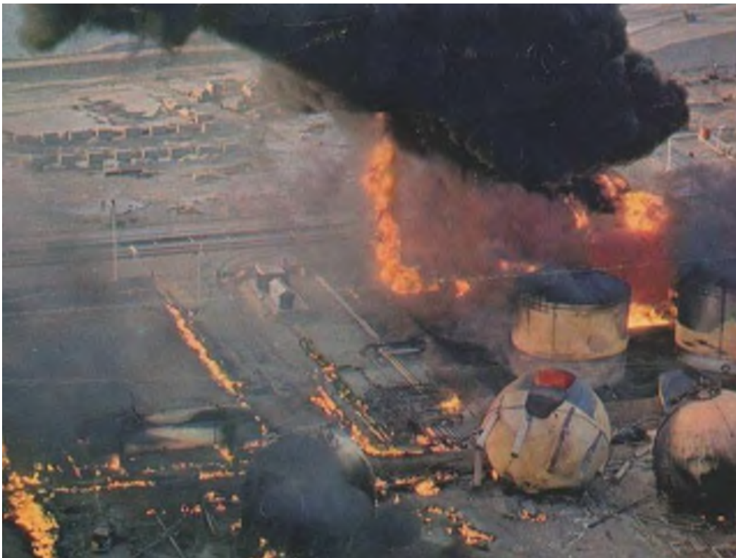
3. ábra: Feyzin LPG tartályok robbanást követően
