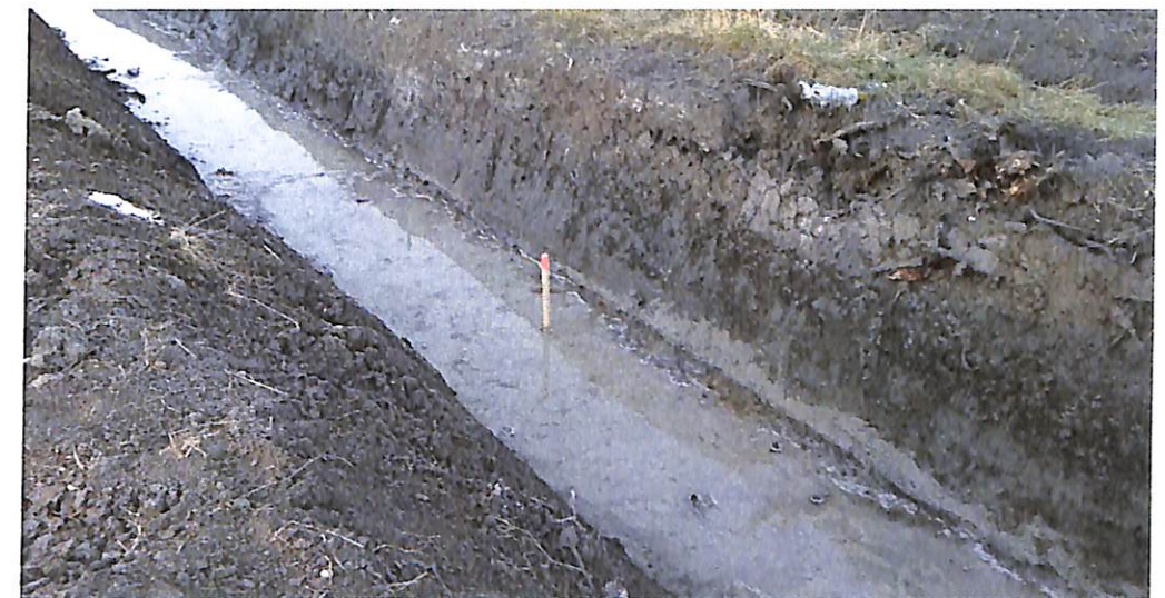
12. ábra – Kenderföldi árok kivitelezése
