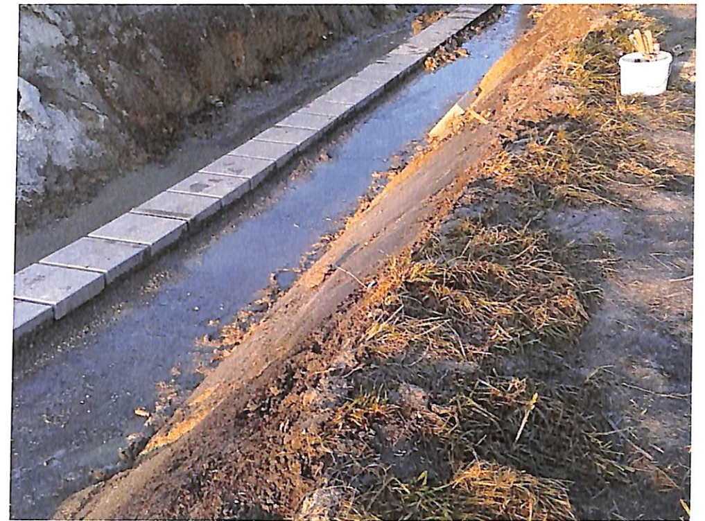
11. ábra – Kenderföldi árok kivitelezése
