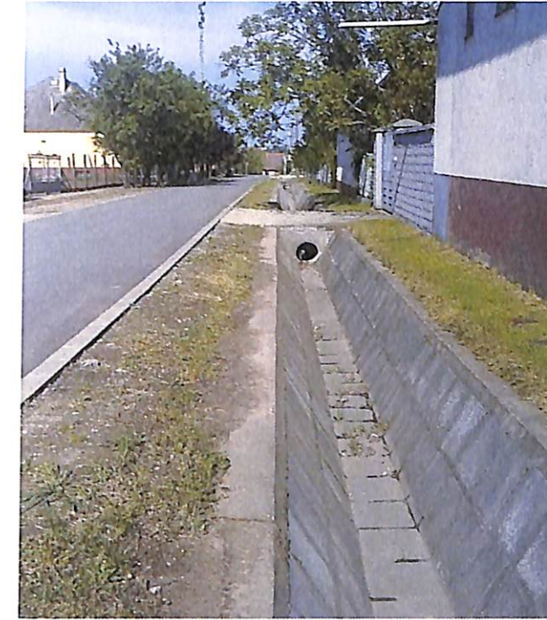
18.ábra – Dunaföldváron betonlapokkal burkolt árokszakas
