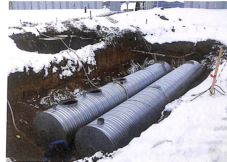
14. ábra – Tározó beépítése [Tubo Hungária Kft.]
