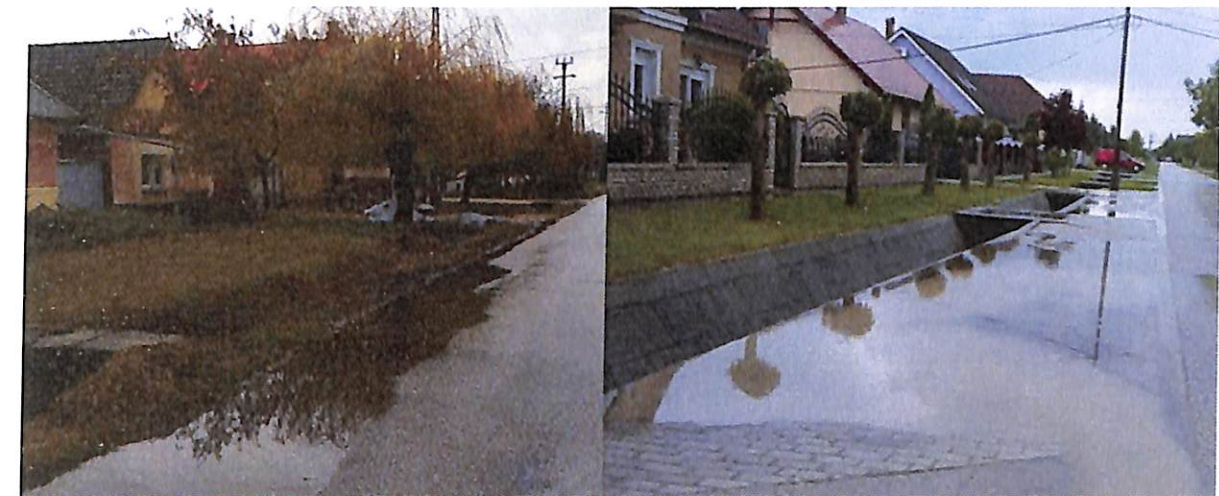
7. ábra – Elvezető rendszerbe be nem jutó vizek a burkolaton
