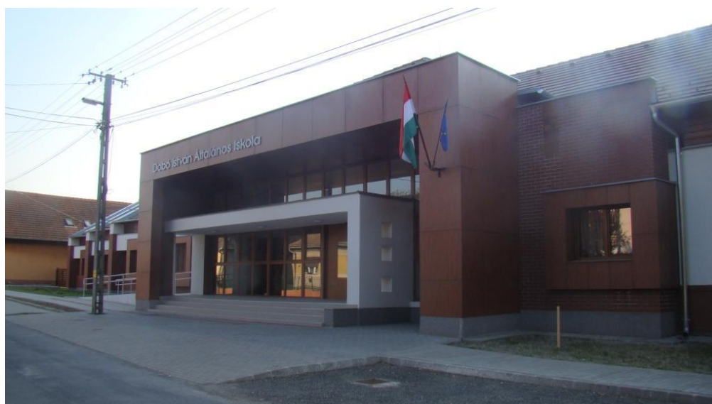
4. ábra A megújult Általános Iskola épülete (Forrás: saját fotó)
