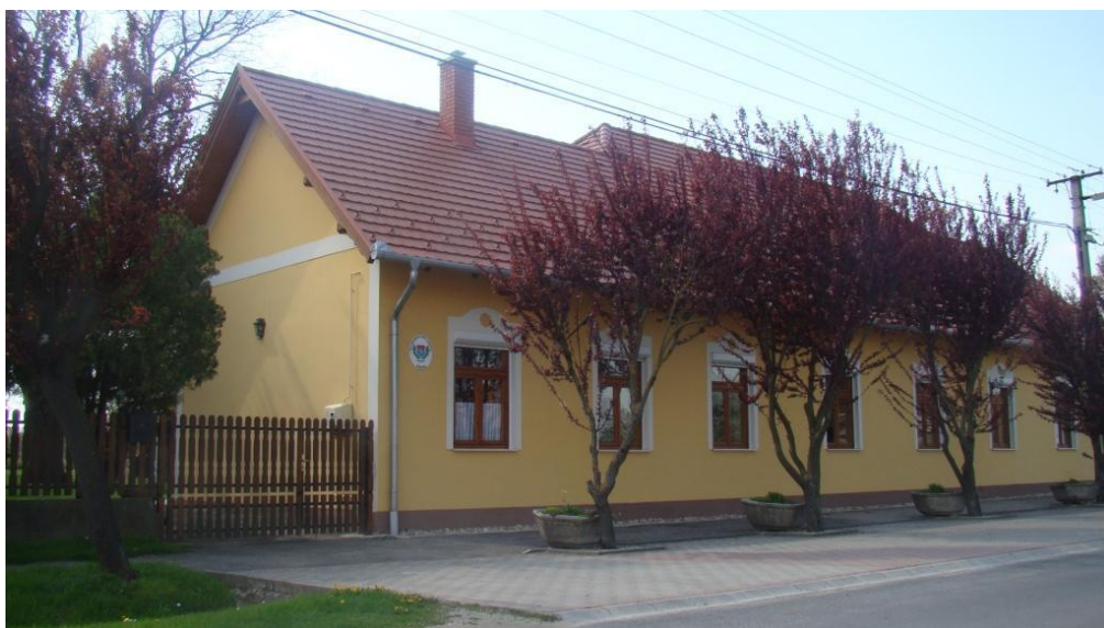
10. ábra A vörsi Községháza (Forrás: saját fotó)
