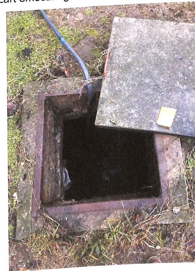
17. kép: Zárt emésztő gödör, szivattyúcsővel
