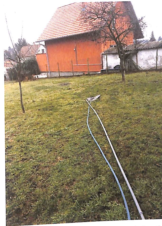
18. kép: Emésztőből kivezetett híg szennyvíz kerti elhelyezése
