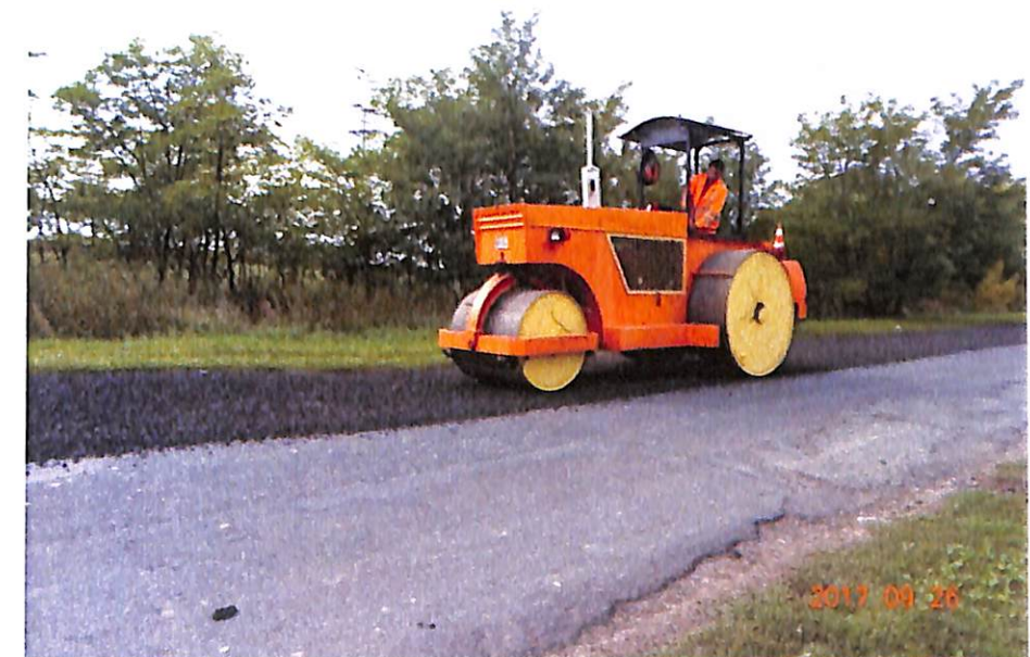
15. kép: Henger építés közben
