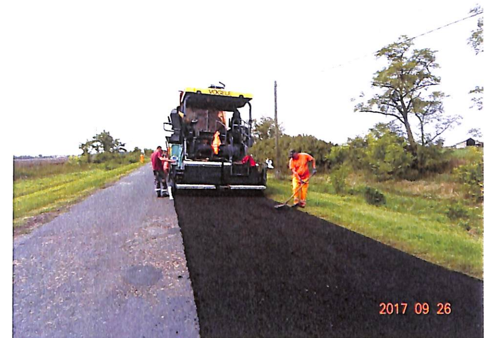
13. kép: Mart aszfalt terítése finisherrel
