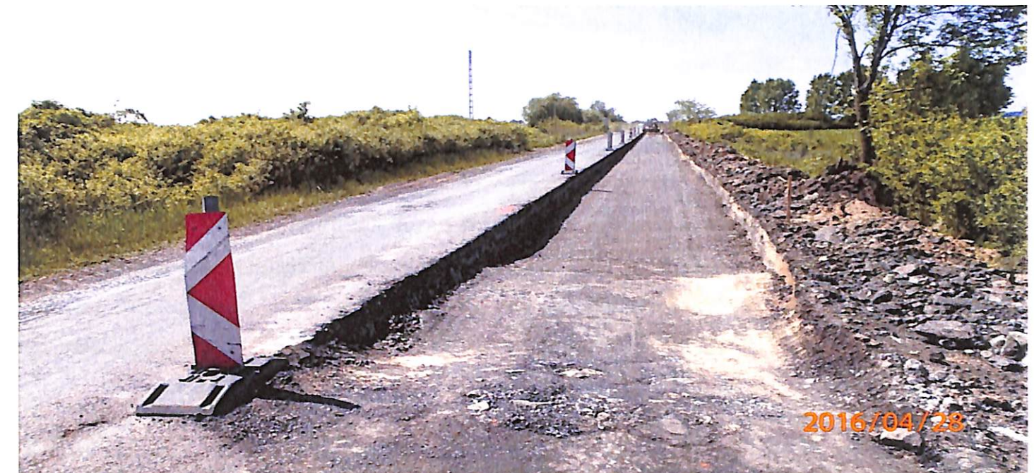
4. kép: Pályaszerkezet csere (Forrás: Magyar Közút Nonprofit Zrt.)
