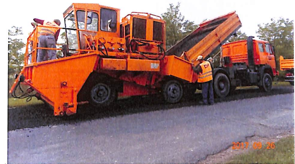
14. kép: Zúzalékterítés géplánca
