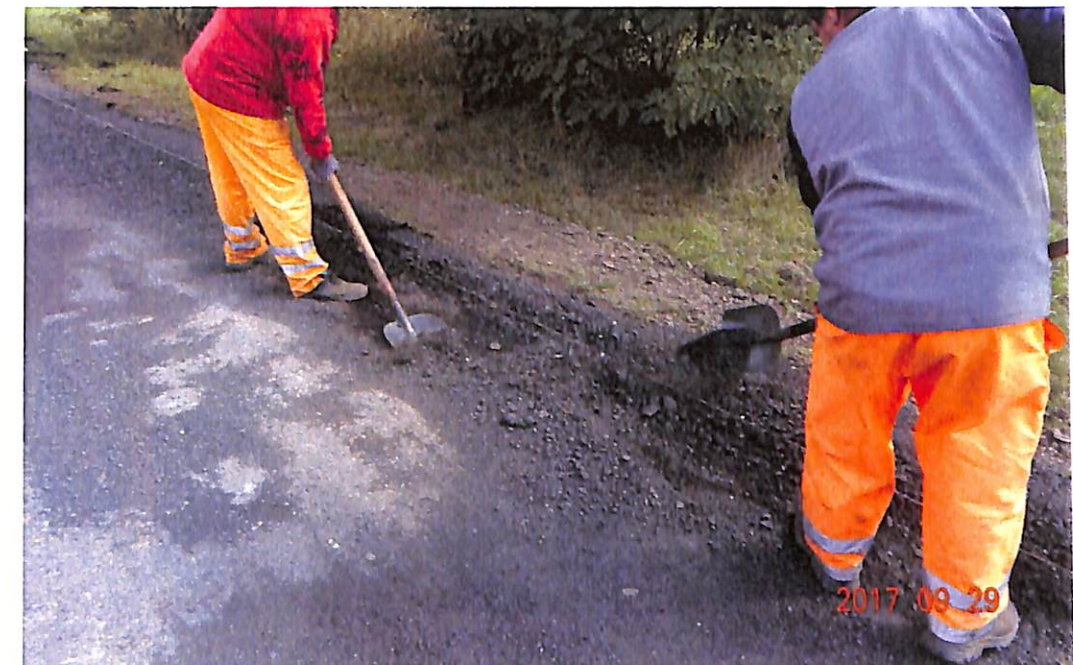
18. kép: Megtámasztó mellékelés készítése
