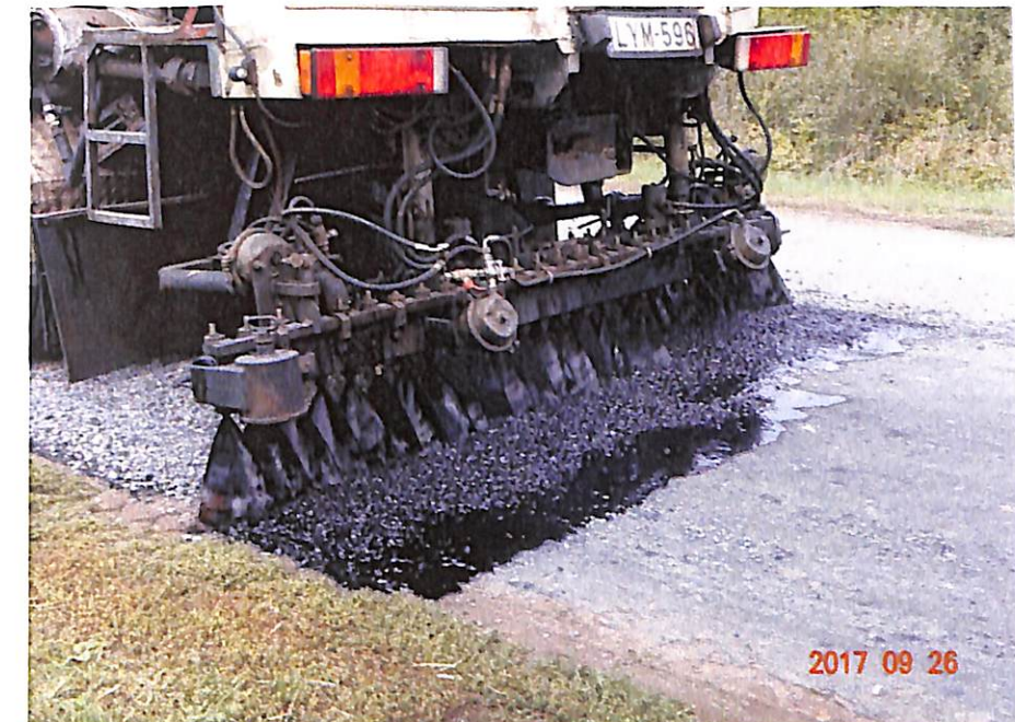
16. kép: Bitumenszórás
