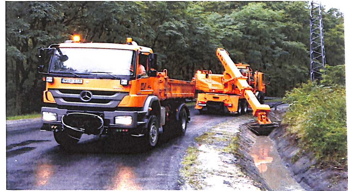
3. kép: Vízvezető árok készítése (Forrás: Magyar Közút NZrt.)
