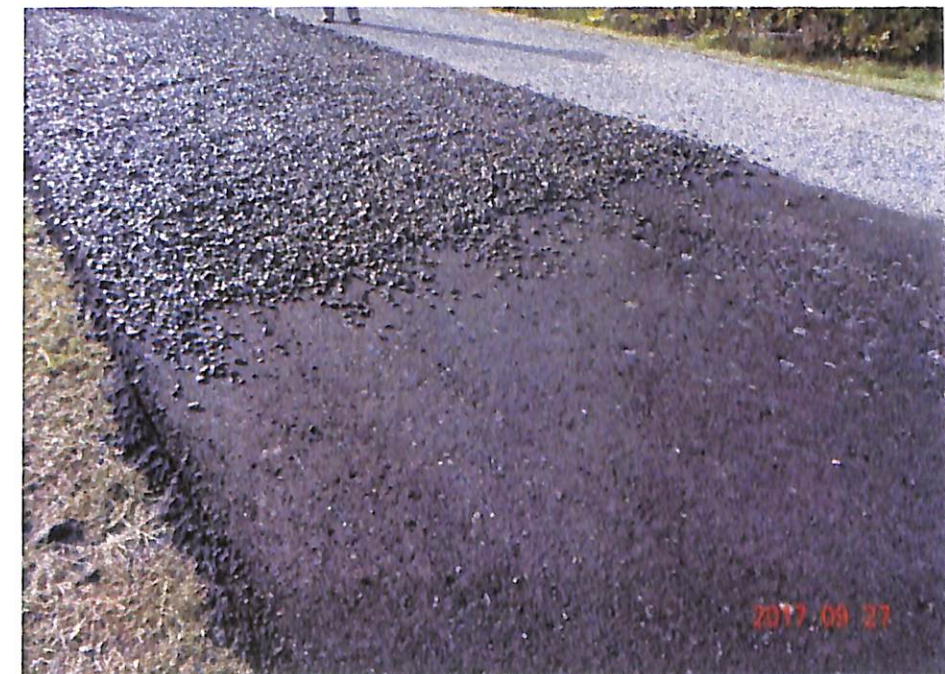
17. kép: Mart aszfaltra készülő felületi bevonat munkaközi építése
