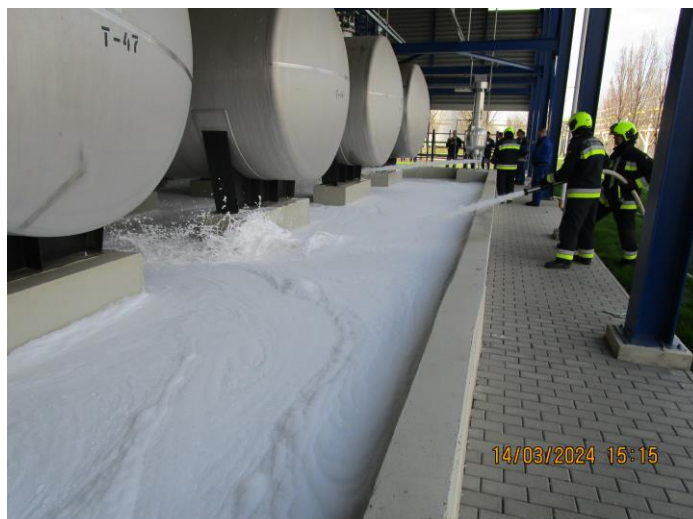
23. ábra: Felfogótér habbal való letakarása
