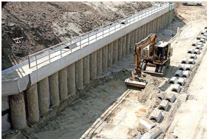
9. ábra: Cölöpfal (Munkatérhatárolás tervezési kérdései-munkatér határoló szerkezetek)
