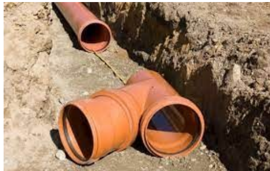
9. ábra KG-PVC műanyagcső [9]
