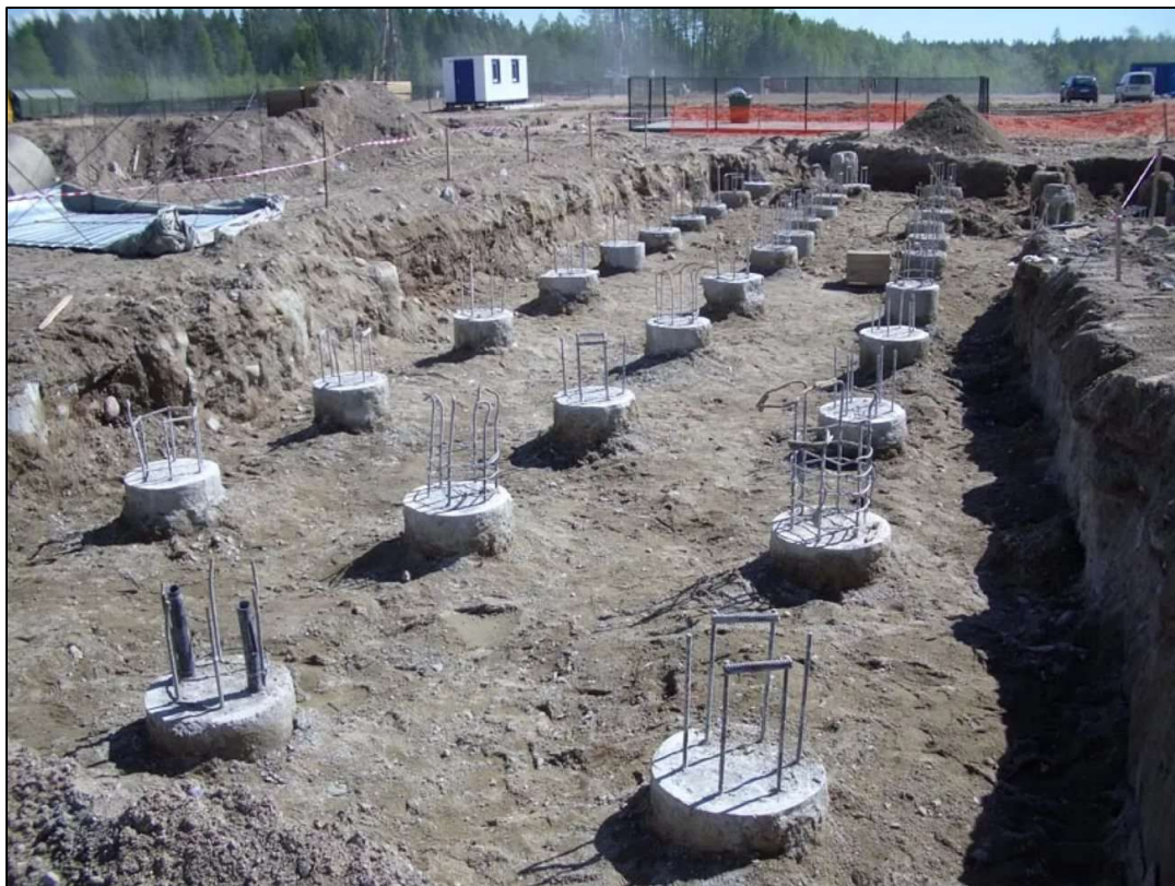
18.ábra. Kész rövid fűrt cölöpalapok, [18]
