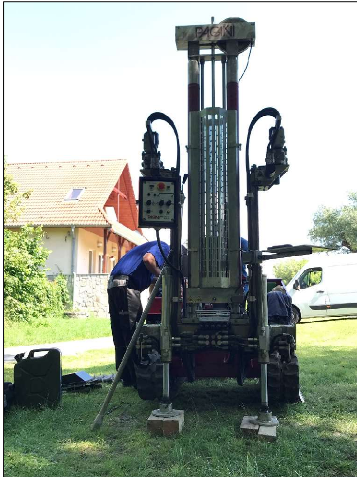
12.ábra. Dinamikus szondázás előkészítése (Forrás: saját kép)
