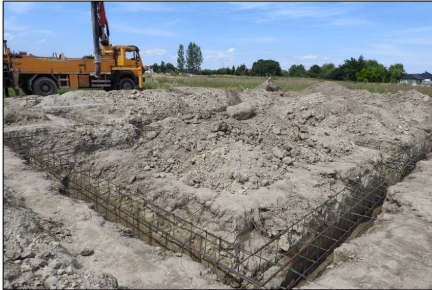
13.ábra. Vasalt sávalap, betonozás előtti állapot, [14]
