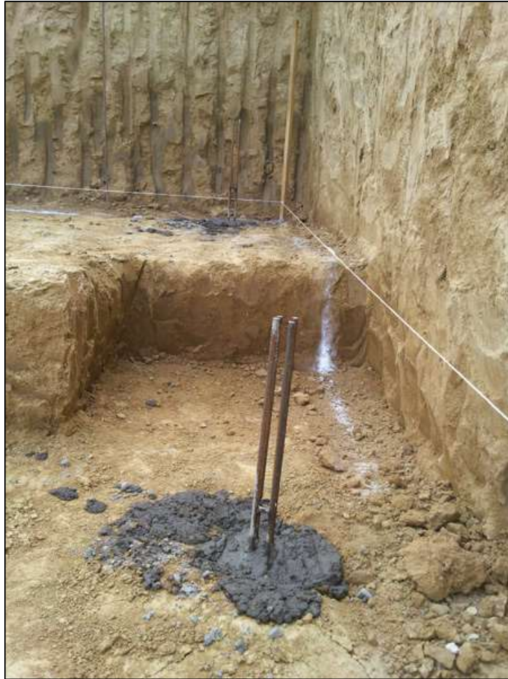
25.ábra. Vasalt, betonozott mikrocölöp, [27]
