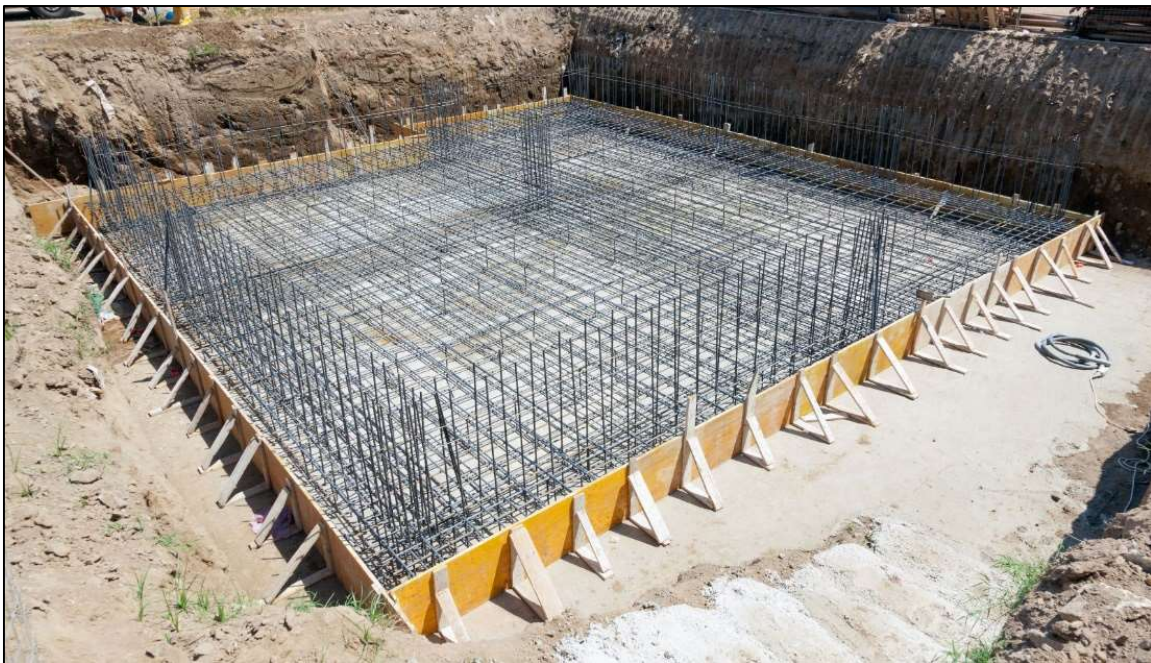
17.ábra. Vasalt lemezalap, betonozás előtti állapot, [17]
