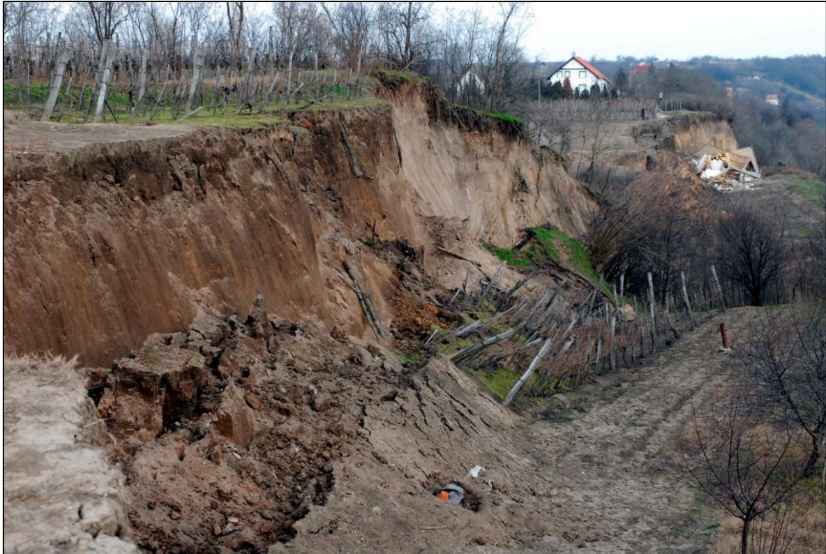
2.ábra. Gravitációs felszínmozgás, 6-os főútra omló löszfal, [3]
