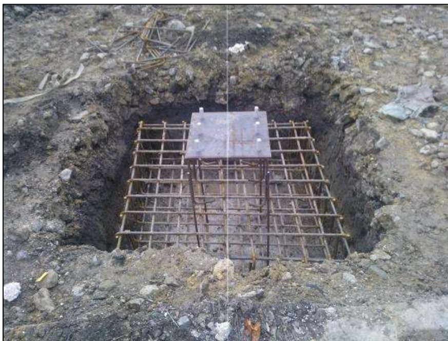
14.ábra. Vasalt pilléralap, betonozás előtti állapot, [15]
