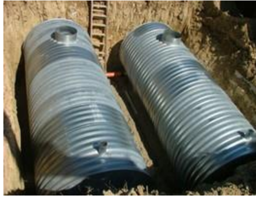
25. ábra: Pureco acél tározó [19]
