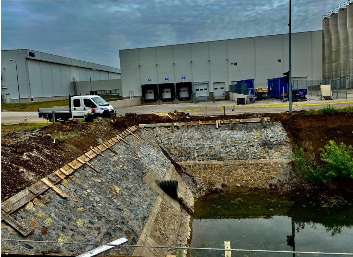
28. ábra: Burkolt részüvel ellátott víztározó árok
