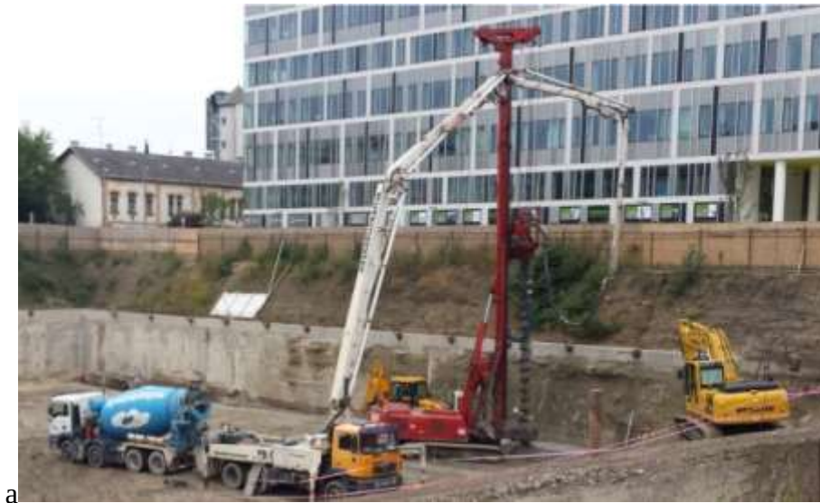
44. ábra: CFA cölöp készítése [9]
