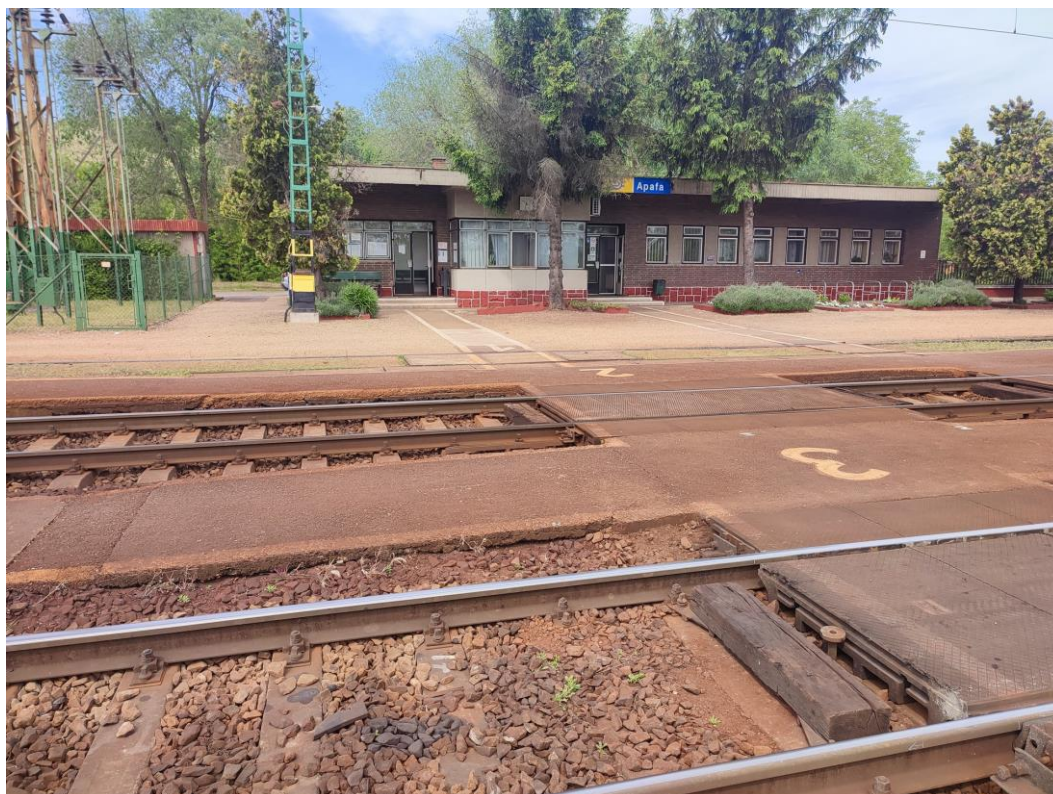
3. kép: Az állomás felvételi épülete
