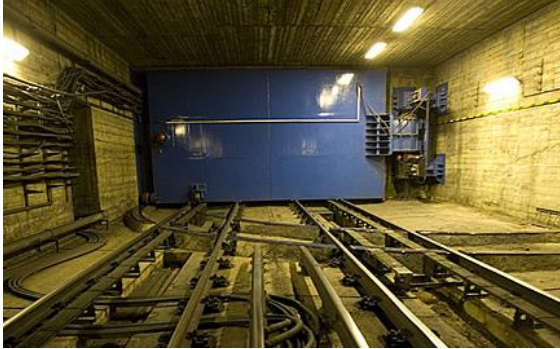
4. ábra. Budapesti 3-as metróban található elzáró kapu
