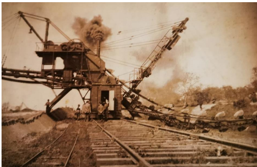
9. ábra: A Duna-völgyi-főcsatorna (Kanális) ásása Kecel határában az 1920-as években a Báger nevű kotrógéppel (forrás: Kecel Könyv) [3]
