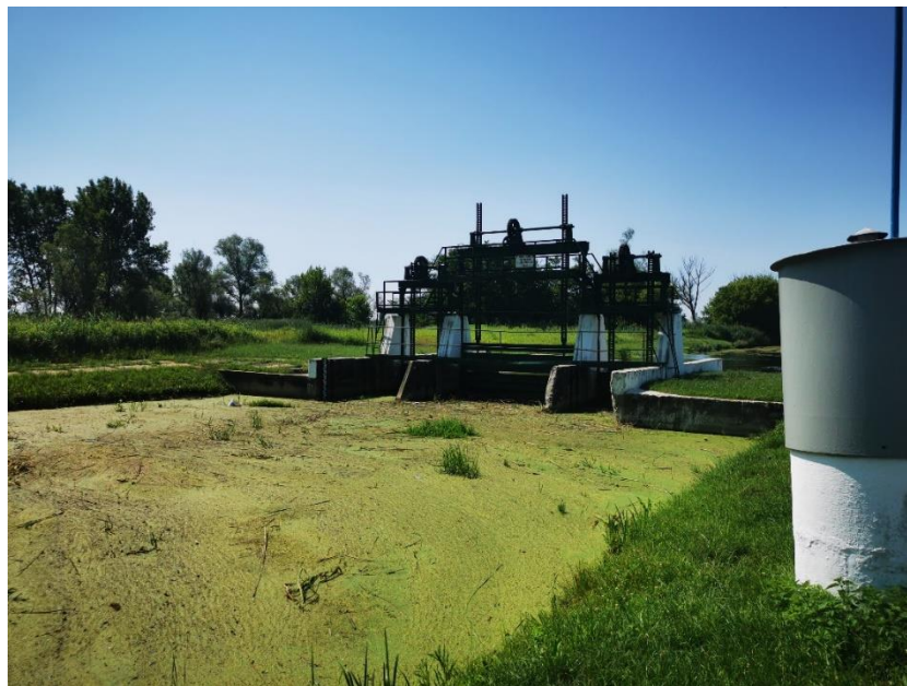
23. ábra: Duna-völgyi-főcsatorna "zsilip" (saját fotó)
