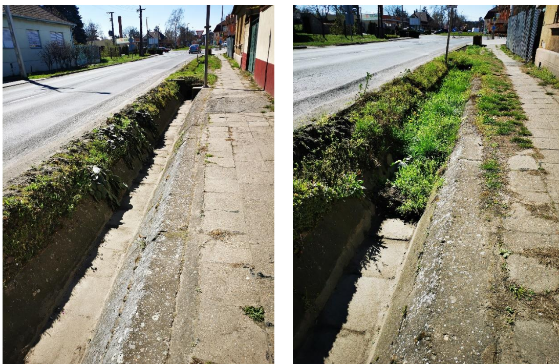
52. ábra: Árok megfelelő és nem megfelelő karbantartása (saját fotók)
