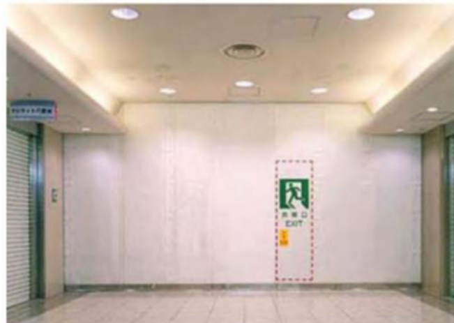
5. kép Tűzvédelmi rekesz (ernyőtípus ajtóval)
