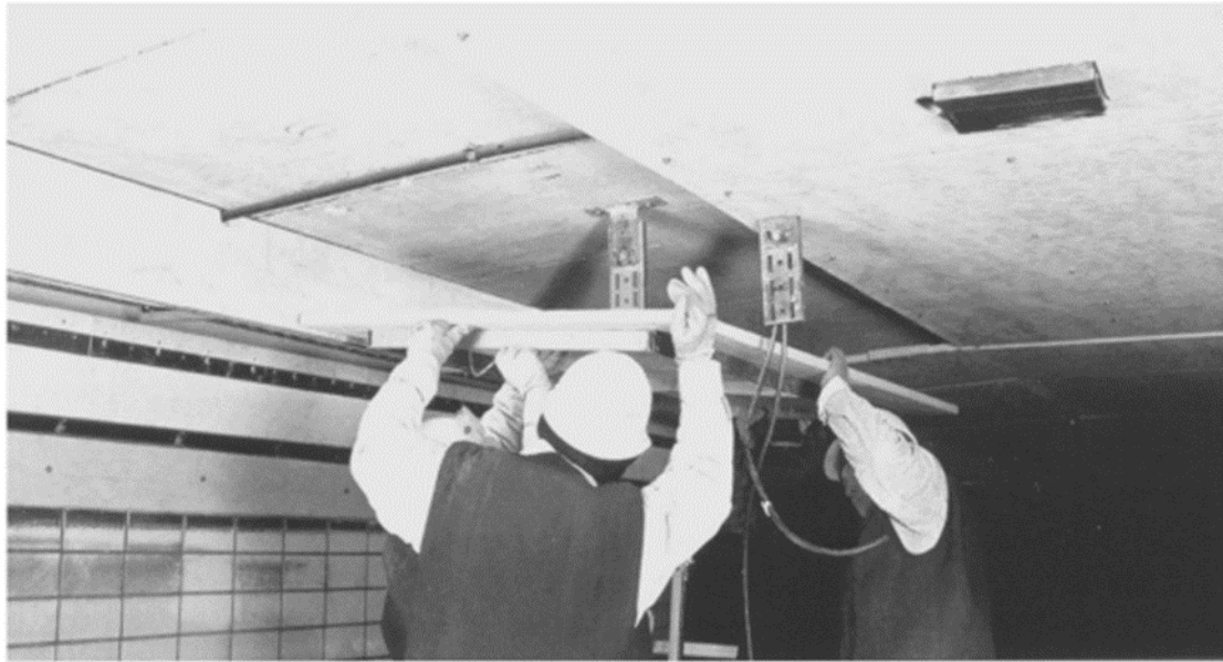
2. kép A Promatect alagútburkolati rendszer [BEARD ÉS CARVEL, 2012]
