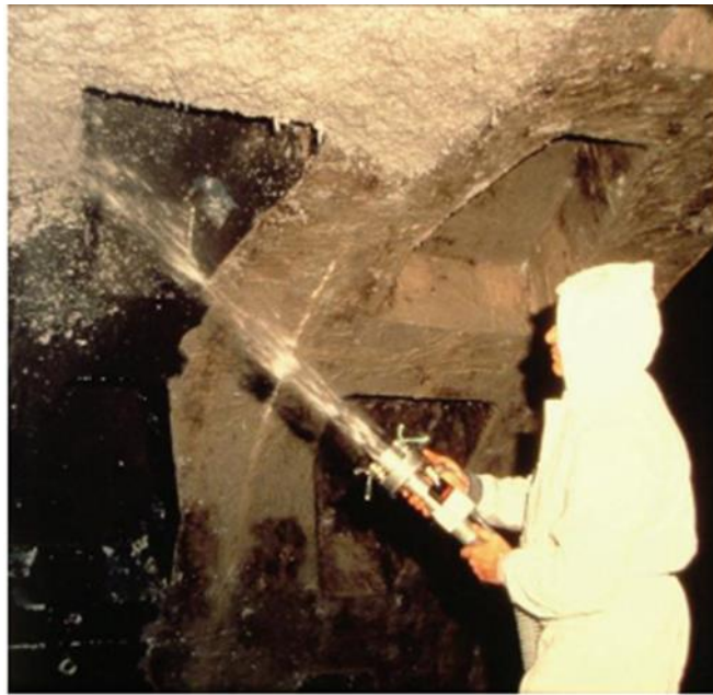
1. kép Különleges vakolat tűzálló burkolat metróalagútban [HAACK, 2008]
