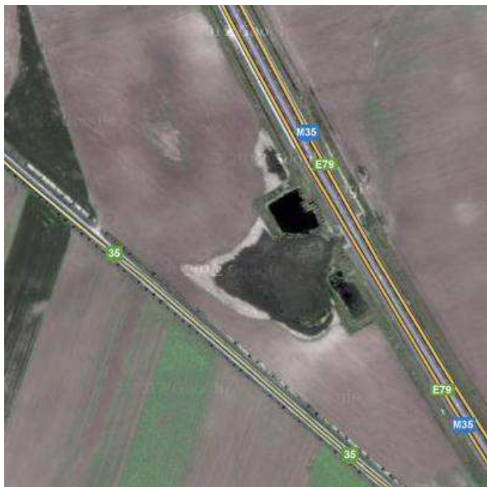
18. ábra alultervezett záportározó előtti a környező földterületet.
