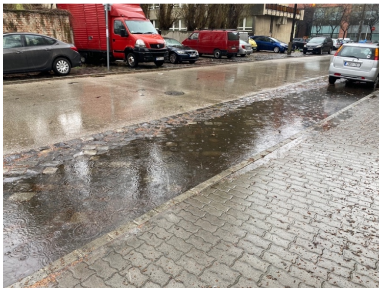
30. kép - Felgyülemelő csapadék a hibás lejtések miatt
