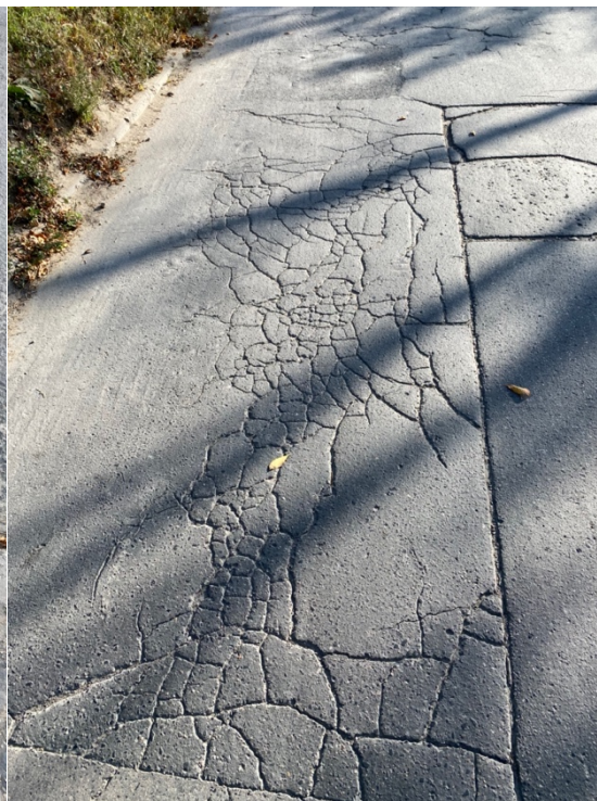
22. kép – Mozaikrepedés
