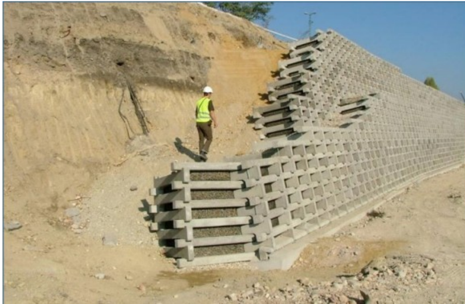
3.ábra: Előregyártott vasbeton elemes máglyafal (Támszerkezetek I.)
