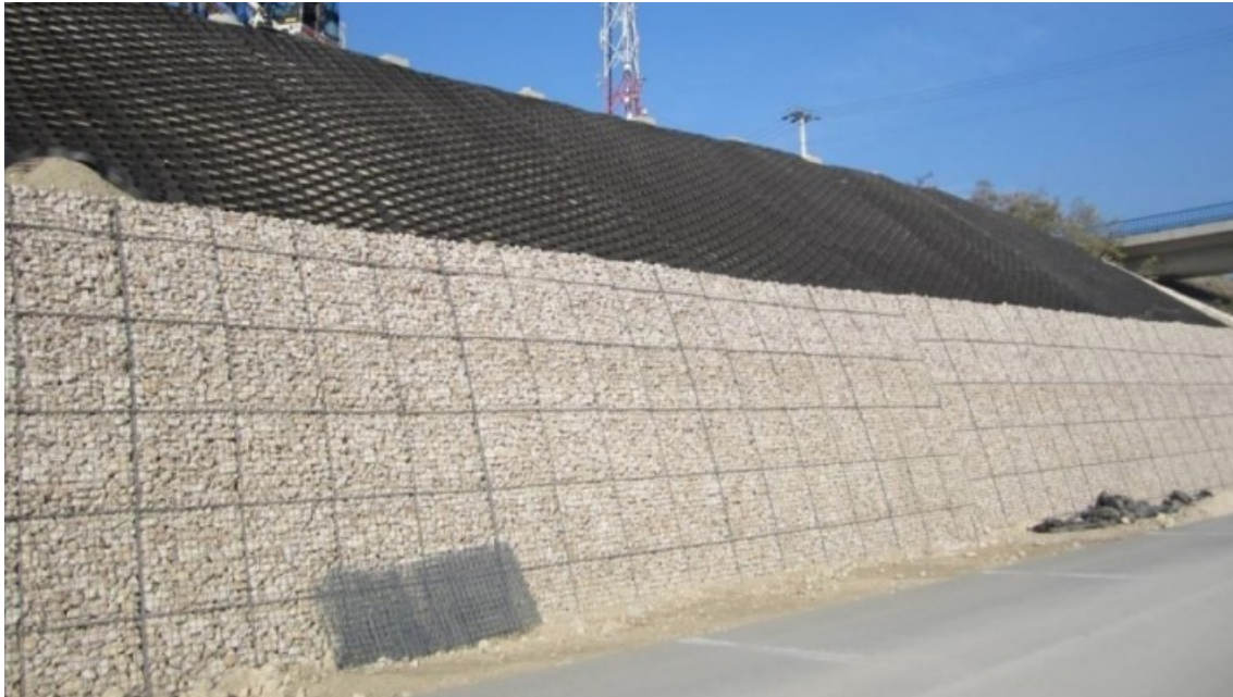
4.ábra: Gabionfal (Támszerkezetek I.)
