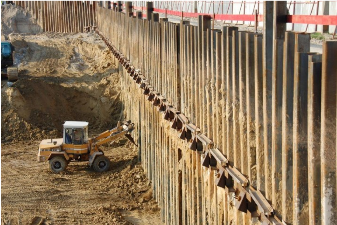
5.ábra: Szádfal (Munkatérhatárolás tervezési kérdései-munkatér határoló szerkezetek)
