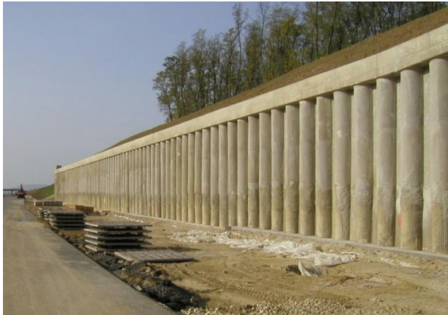
6.ábra: Cölöpfal (Munkatérhatárolás tervezési kérdései-munkatér határoló szerkezetek)
