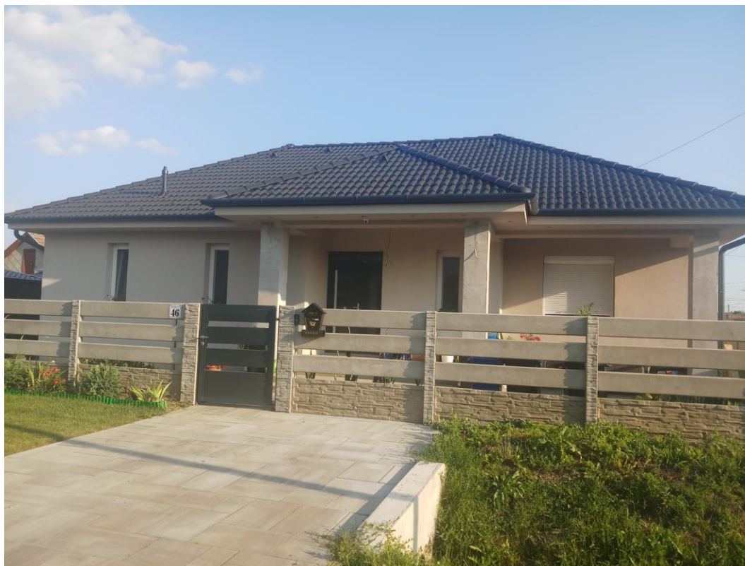
5.3.8 ábra: A képeken a megépült családi ház látható Forrás: [4]
