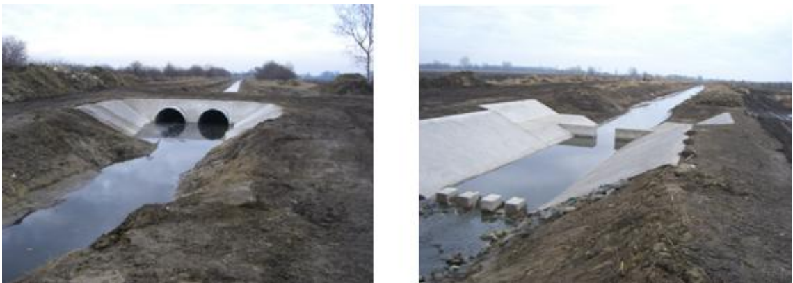
II.8. ábra: Áteresz és energiatörő fogak
