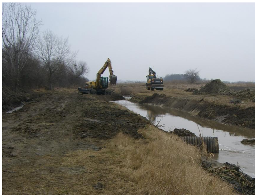
II.9. ábra: Kivitelezés-földmunkák
