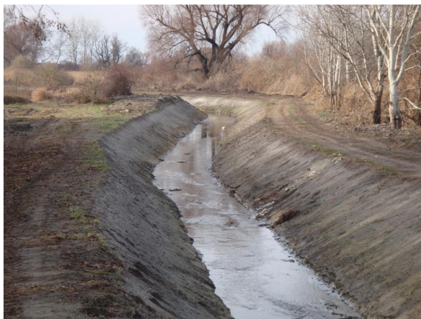
II.1. ábra: Vízszabályozásra tervezett patak
