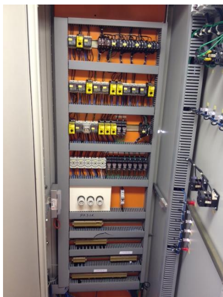
9. kép - Pörösi Szivattyútelep villamos rekonstrukció
