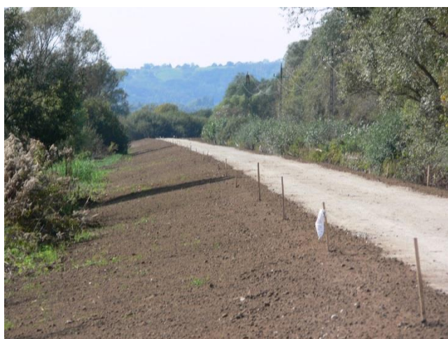
8. kép - Zala balpart töltéserősítés
