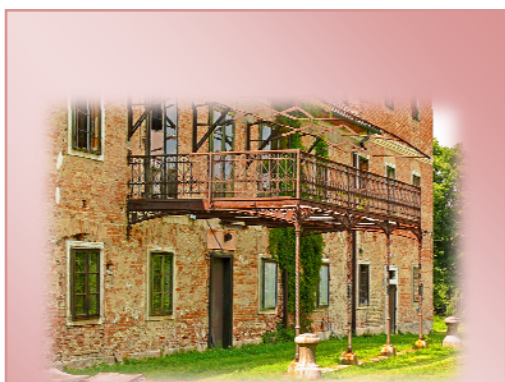
2.11. ábra Felújítás előtt, 2008-ban
