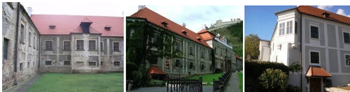
7. ábra Püspöki Palota helyreállítási munkálatai után
