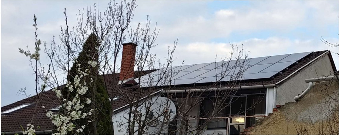
6. Kép Panelok elhelyezése a DNY tetősíkon
