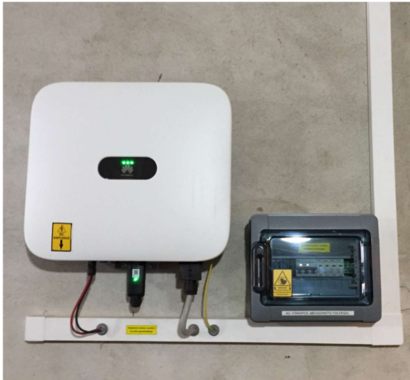
2. Kép AHUAWEI SUN2000-6KTL-M inverter
