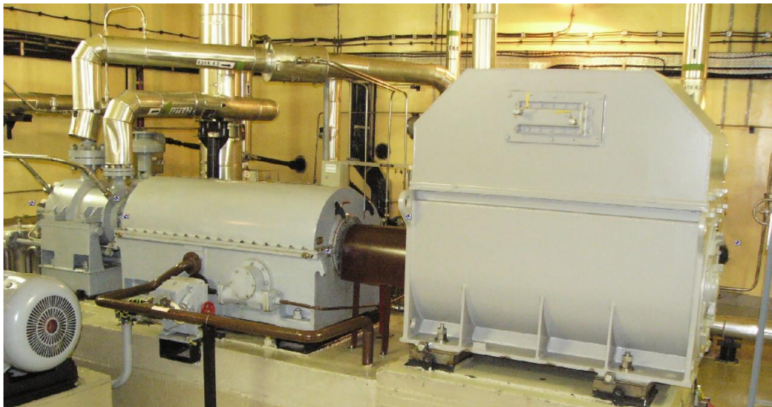
9. ábra Pótvízszivattyú egység JHWA-400 MB-02A motorral 22
