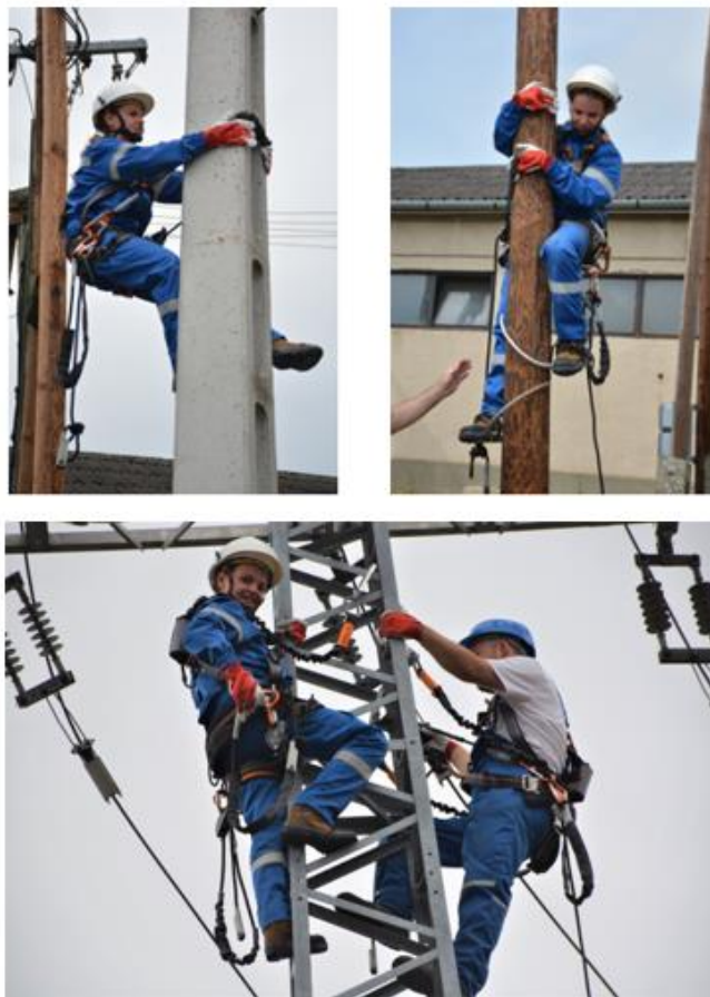
5.1. Beton-, fa-, vasoszlop mászás (Forrás: MVM Émász Áramhálózati Kft. Gyöngyösi régió - Műszaki csoport – Oszlopmászás gyakorlat – fotó: Sidló Tamás)
