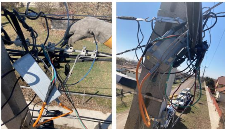
5.2. ábra Regiszter felszerelése a hálózatra kosarasautóból (Forrás: MVM Émsz Árámhálózati Kft. - Gyöngyösi régió - fotó: Garamszegi Ágota
