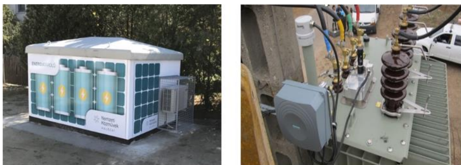
10.1. ábra Akkumulátor telep; Feszültségszabályzó OTR-en (Forrás: MVM Émász Áramhálózati Kft. – Fenntartható DSO - Feszültségproblémák előadás)
