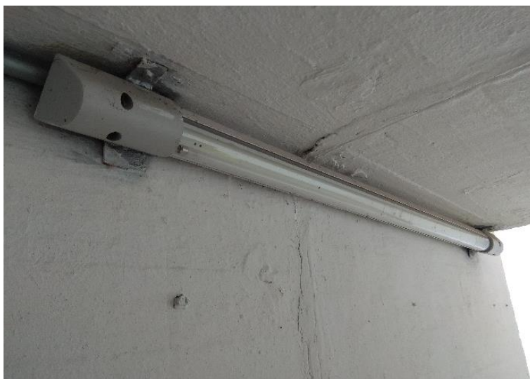
2-4. ábra A gyalogos aluljáróban törött fényforrású világítótest (saját fotó)
