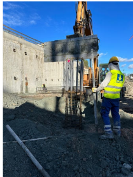
42. ábra: Armatúra elhelyezése kotró segítségével (saját készítés)
