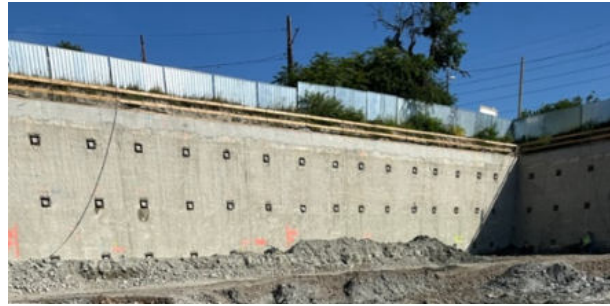
26. ábra: Elkészült résfal (saját készítés)
