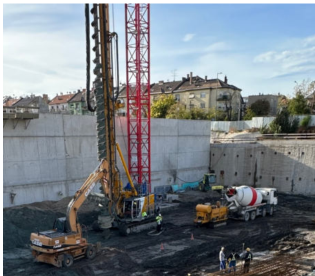
28. ábra: CFA cölöpözés géplánca (saját készítés)
