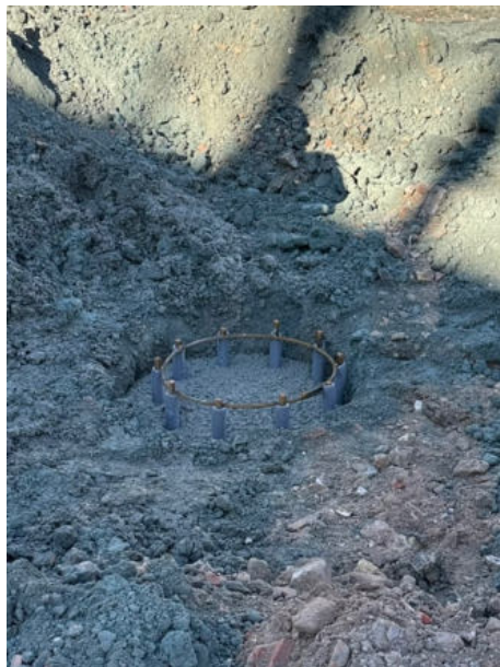
43. ábra: Elhelyezett armatúra (saját készítés)
