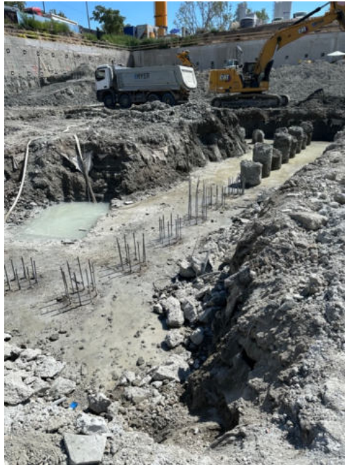
47. ábra: Visszavéssett cölöpök (saját készítés)
