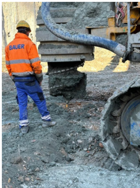
36. ábra: Pontraállítás a fúrógéppel (saját készítés)
