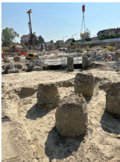
46. ábra: Cölöpcsoport előkészítése szerelőbetonozáshoz (saját készítés)
