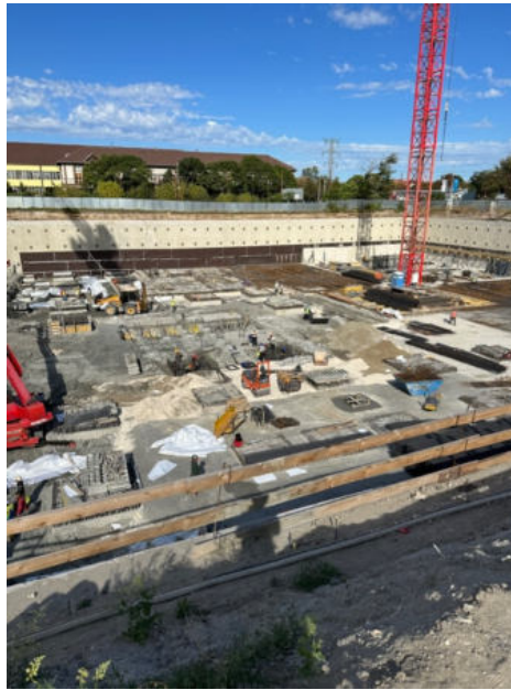
48. ábra: Fejtömbök készítése (saját készítés)
