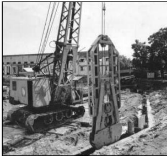
2.15 Kötélfüggesztésű, réskészítő markológép [10]
