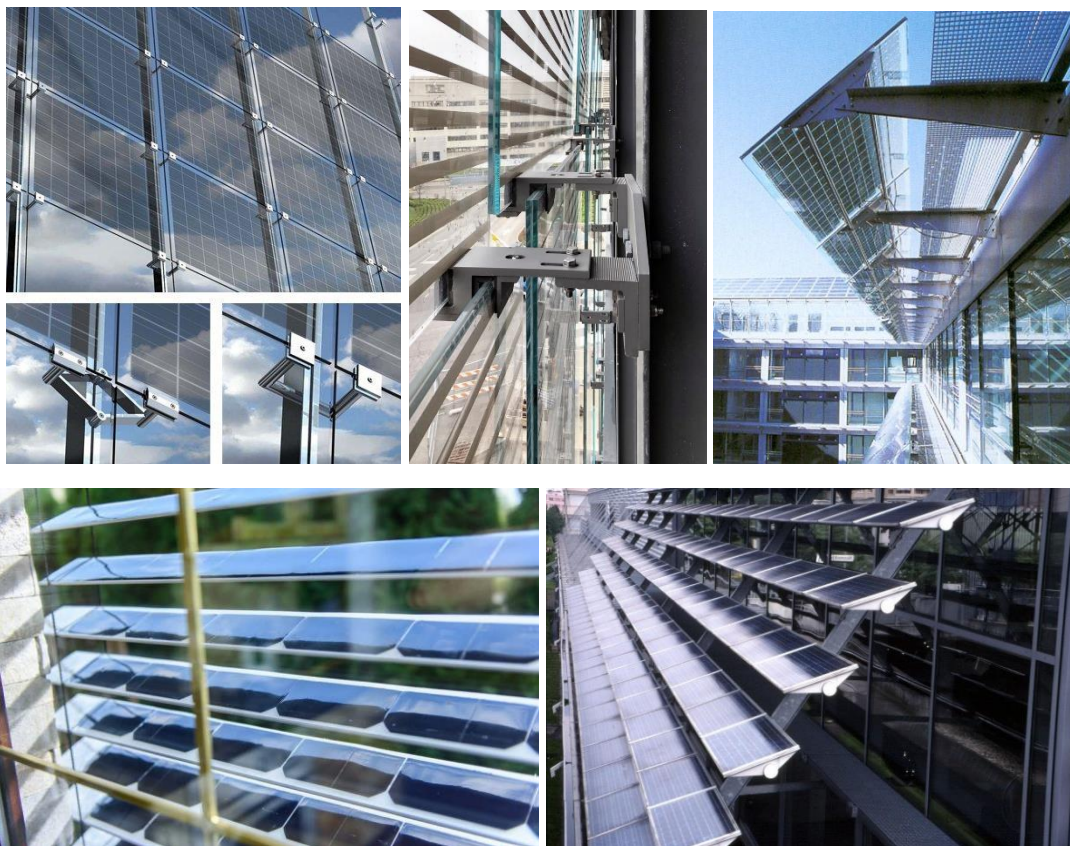
3.22 ábra: Homlokzatra szerelt Napelemes árnyékoló szerkezetek / Forrás: www.archdaily.com
