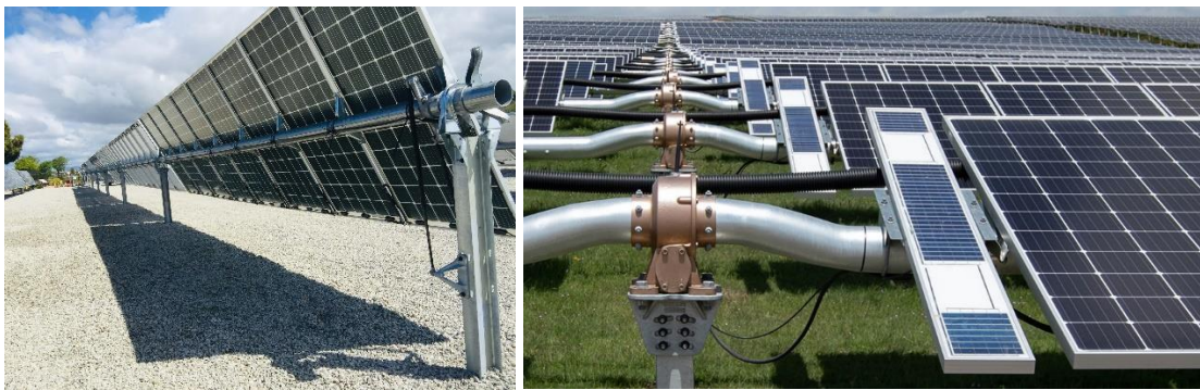
3.34 ábra: Egytengelyes, kelet-nyugat tájolású, valós idejű vezérléssel / Forrás: www.nextracker.com
