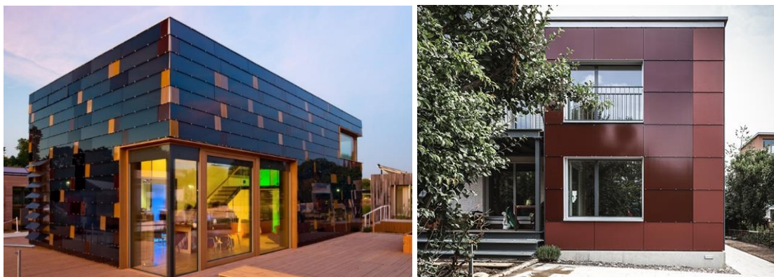
3.23 ábra: Színes szolárhomlokzat/ Forrás: www.baunetzwissen.de , www.eterinit.ch
