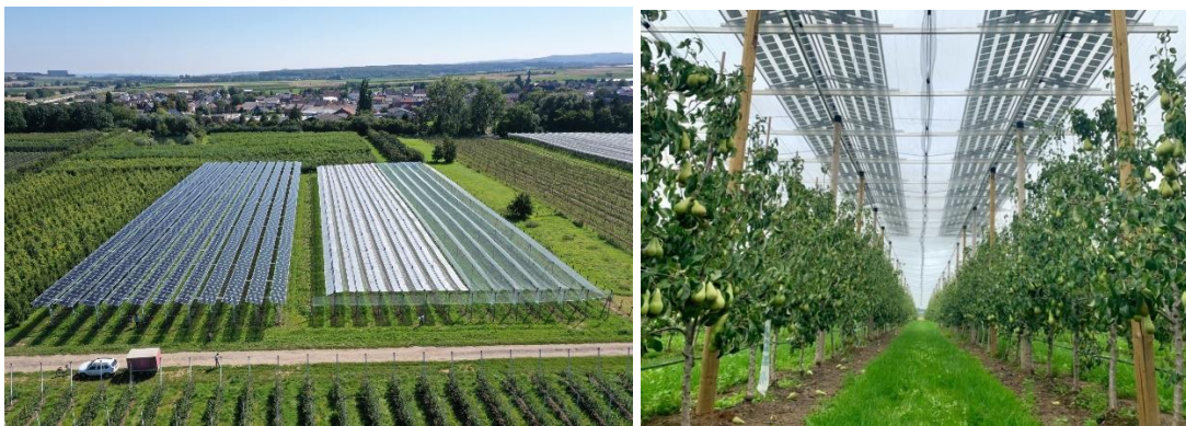
3.39 ábra: APV jégkálóval kombinált magas rendszer/ Forrás: www.ise.fraunhofer.de , www.pv-magazine.com
