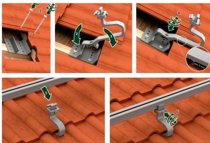
3.3 ábra: Tetőhorgony felszerelése / Forrás: www.sl-rack.com
