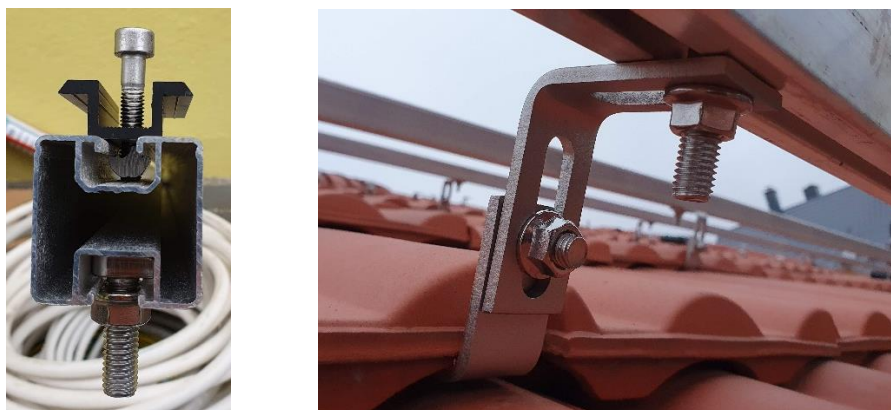
3.12 ábra: Balra Szerelt rögzítősín, jobbra a tetőhorog a sínhez aluról rögzítve / Forrás: szerző saját fotói.
