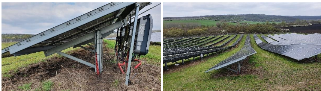
3.30 ábra: Egyállású tartó, kerecsendi 20MW-os erőmű/ Forrás: Szerző saját fotói
