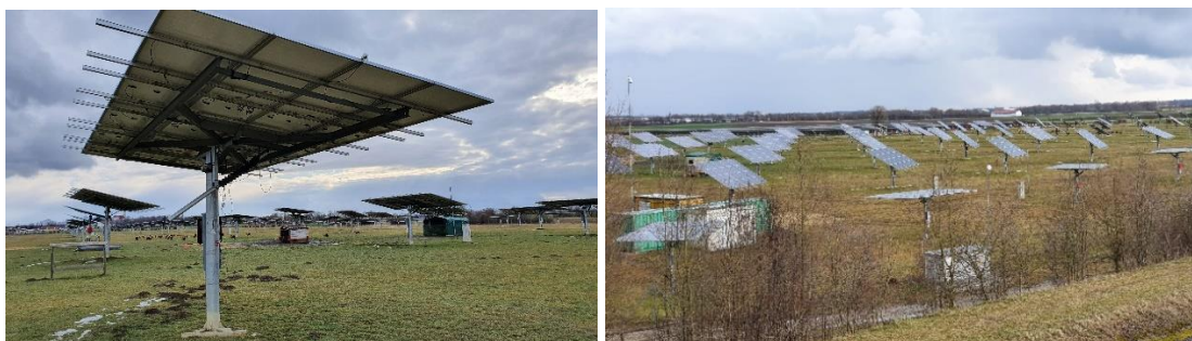
3.37 ábra: Kéttengelyű napkövető Németország Erding mellett/ Forrás: Szerző saját fotói
