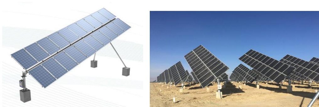
3.35 ábra: Egytengelyes, kelet-nyugati tájolású, döntött panel / Forrás: www.raysolar.com
