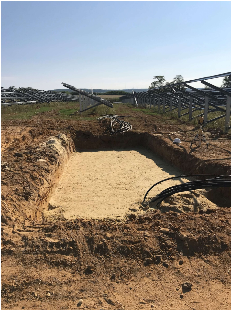
17. ábra Transzformátor alap
