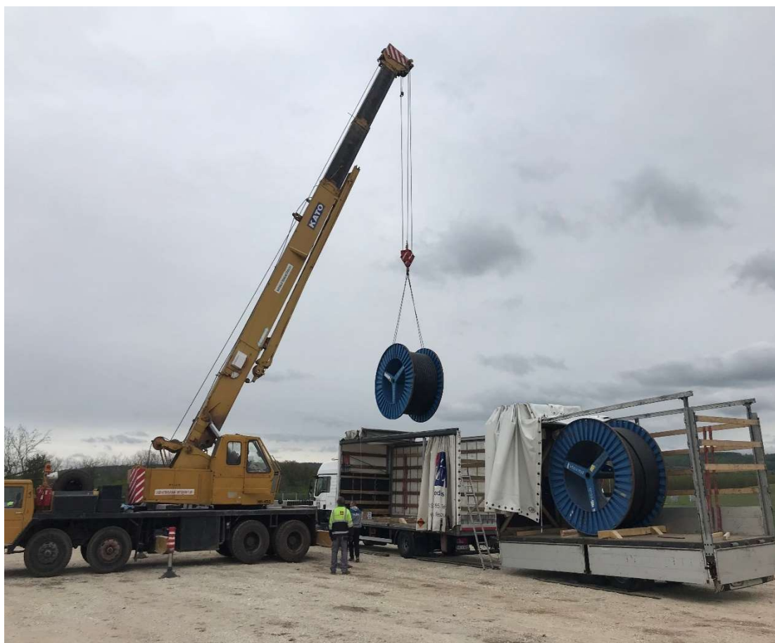
9. ábra Kábeldobok daruzása
