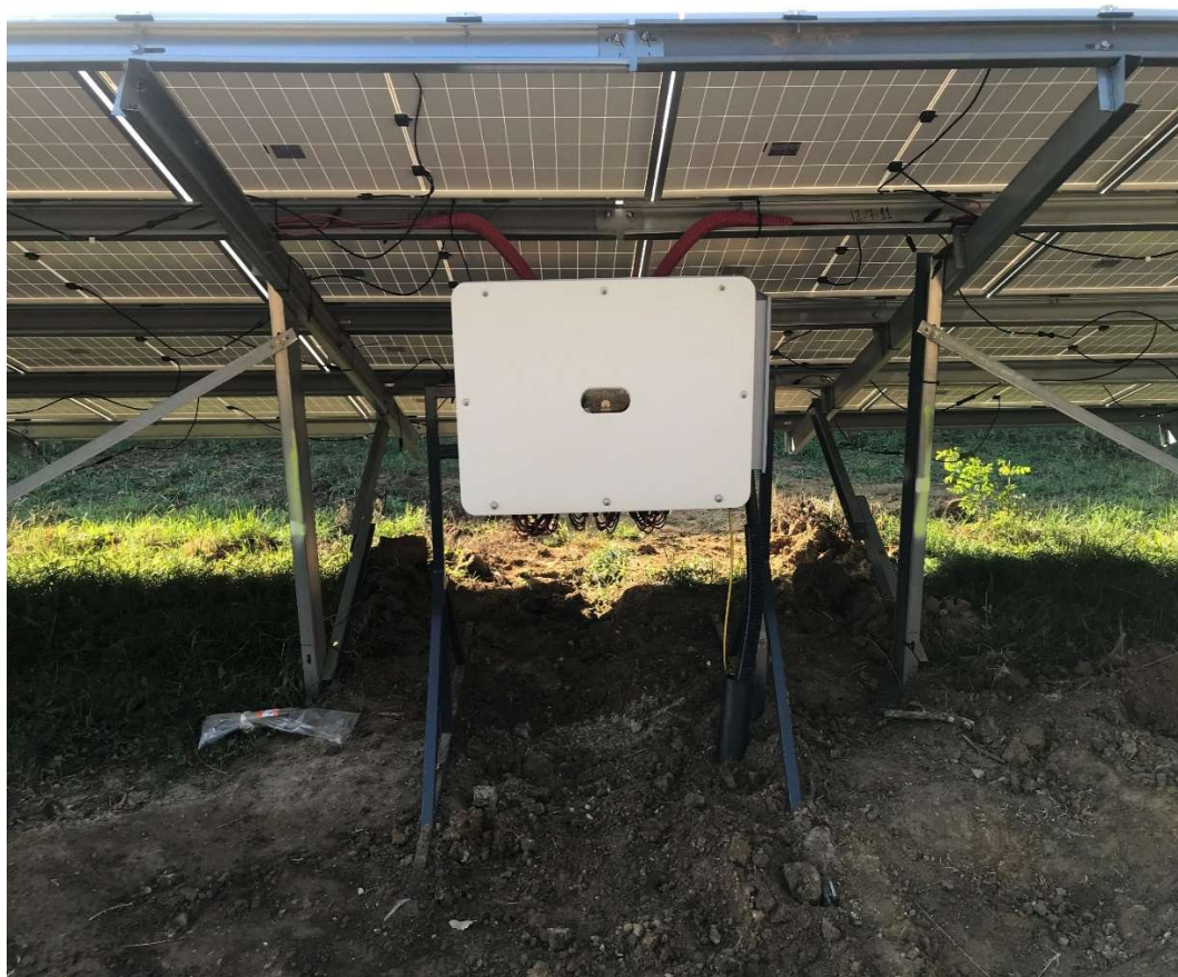
19. ábra Az inverterek telepítése
