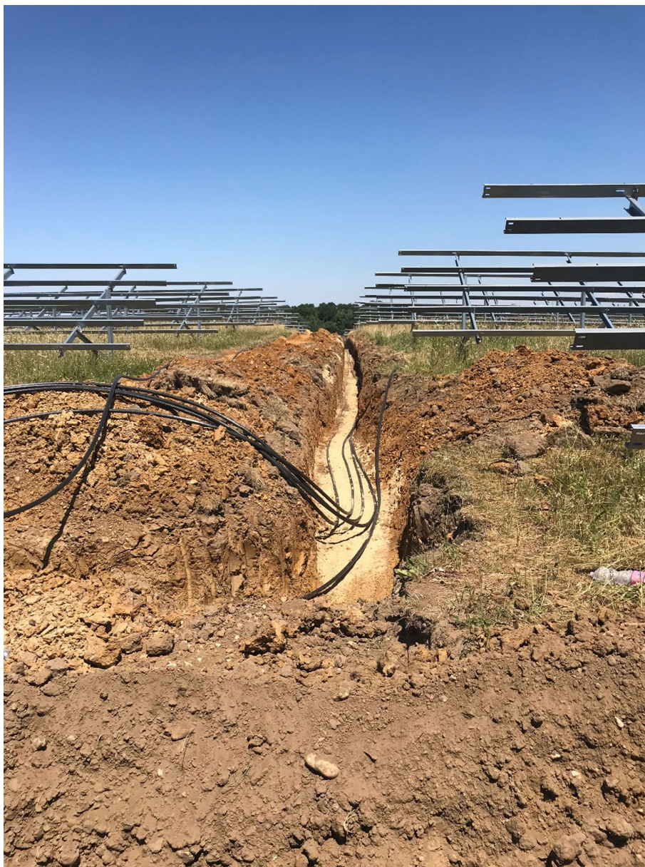
11. ábra KÖF kábelfektetés
