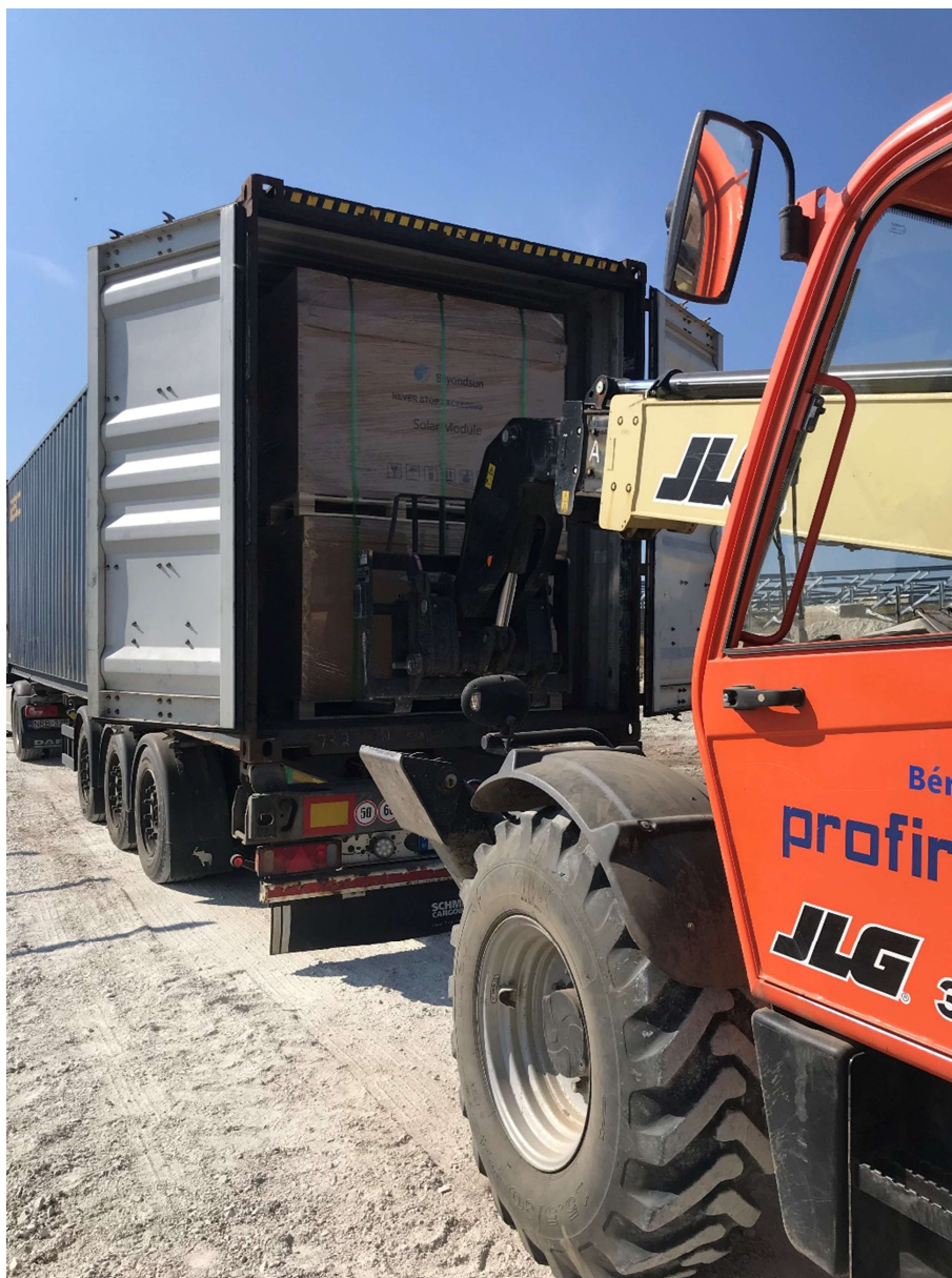
21. ábra A napelem kirakodás
