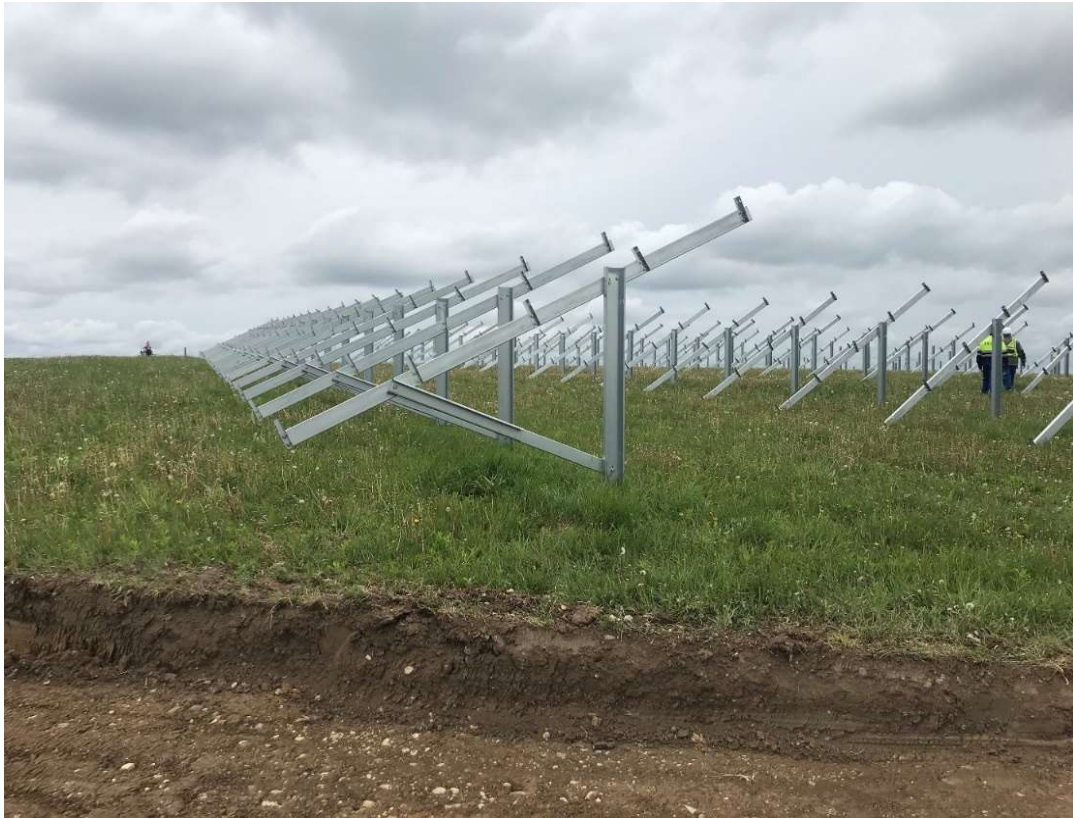
6. ábra Alapkeret szerelés
