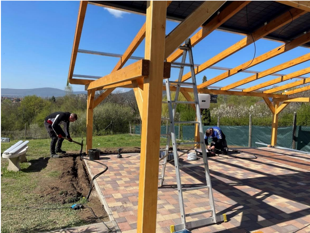
18. ábra AC kábel fektetése a főelosztóig 12 méteren alépítményben; Forrás: saját fotó
