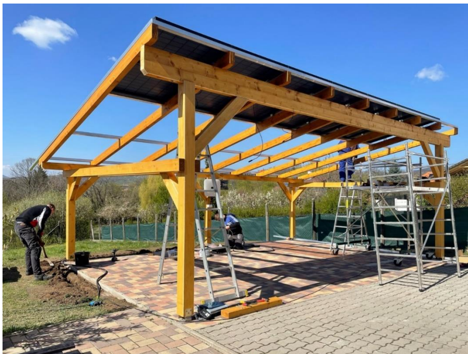
23. ábra napelem tartószerkezet telepítése az előkészített fa tartószerkezetre;
