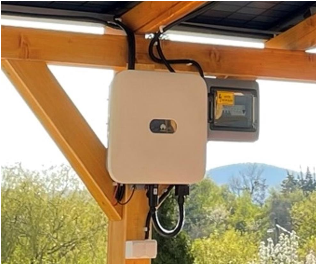
17. ábra A tartószerkezet hátsó középső oszlopára történt rögzítés; Forrás: saját fotó
