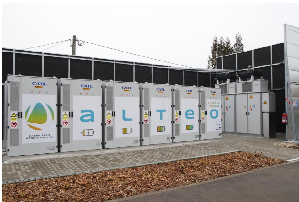
Ábra 9.2: BESS2 12 db rackje (két sorban) és az 5 MW-os inverter [36]
