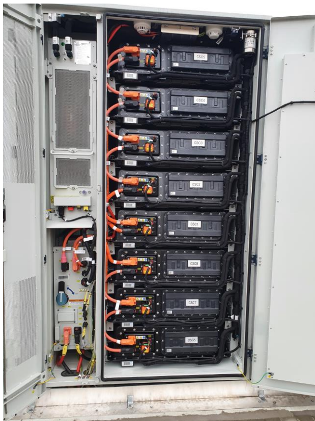
Ábra 9.3: BESS2 1 szekrényének belseje a 8 akkumulátor egységgel [36]
