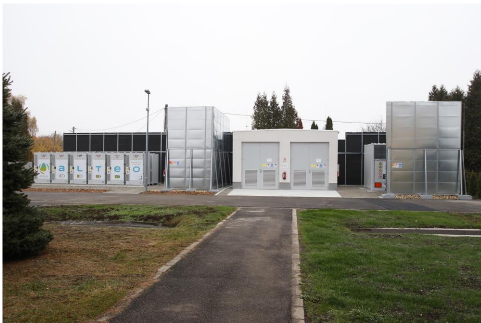
Ábra 9.1: A megvalósult akkumulátoros energiatároló [36]
