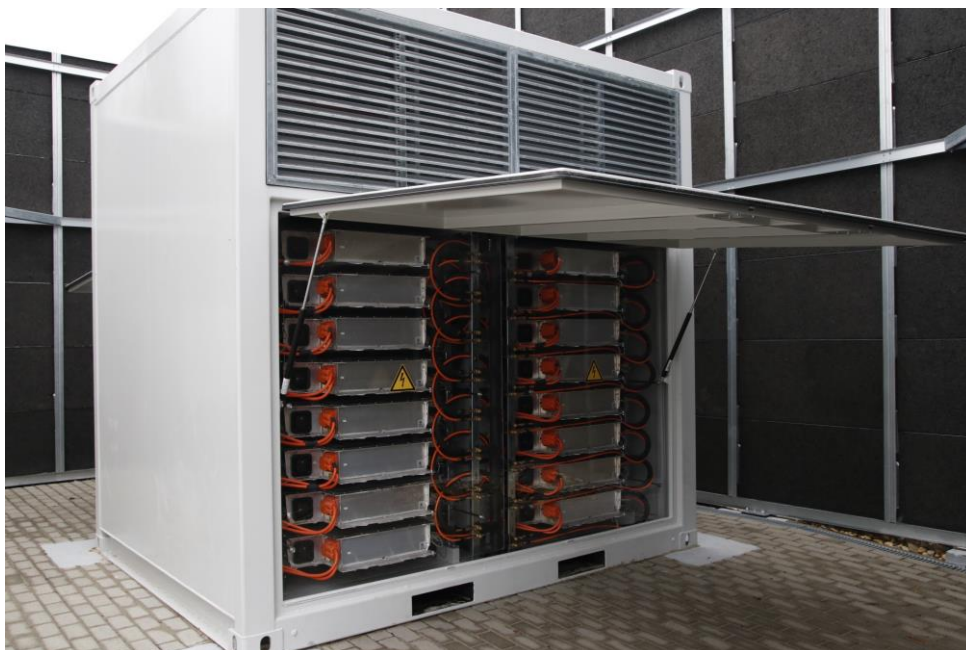
Ábra 9.4: BESS1 konténere, a 16-db BMW I3-mas akkumulátormodulokkal [36]
