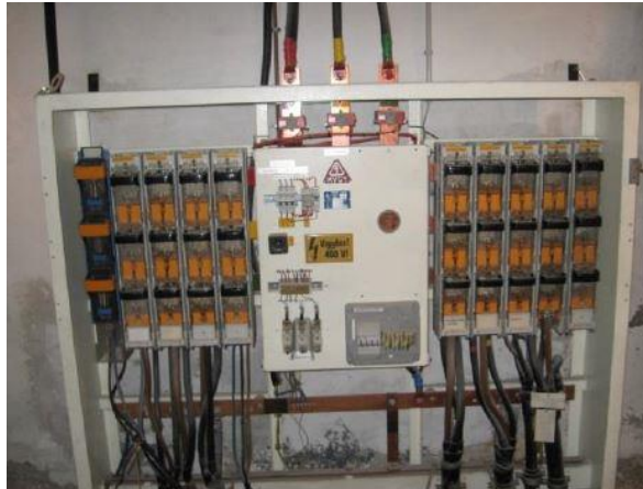
30. ábra Beltéren elhelyezett oldóbiztosítós elosztószekrény [1]
