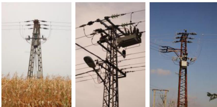
13. ábra Középfeszültségű oszlopok TMOK-val ellátva [9]
