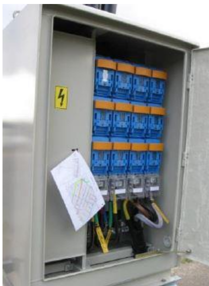
29. ábra Kültéren elhelyezett olvadóbiztosítás elosztószekrény [1]
