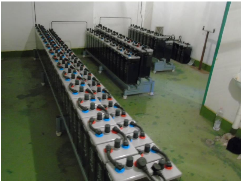
16. ábra 220V-os egyenáramú akkumulátortelep
