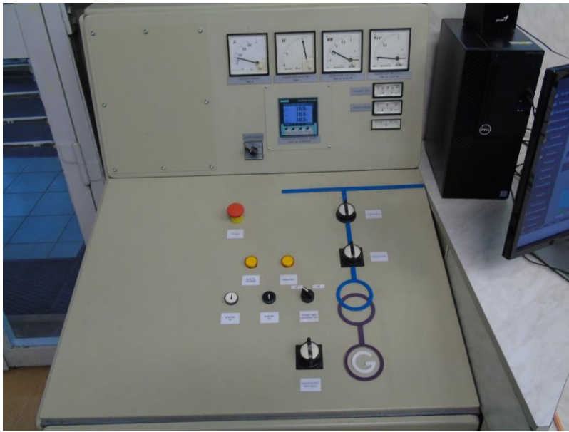
7. ábra Kvassay I. gépegység vezénylőpultja
