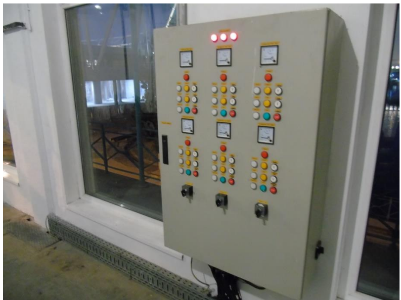
4. ábra Zsilipmozgató kapcsolószekrény
