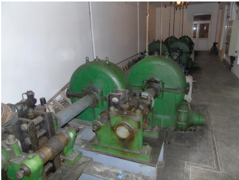
1. ábra Zsilipmozgató hajtómű
