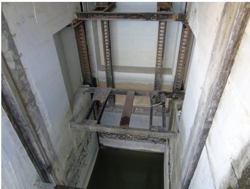
13. ábra Zsilip táblák a fogaslécekkel
