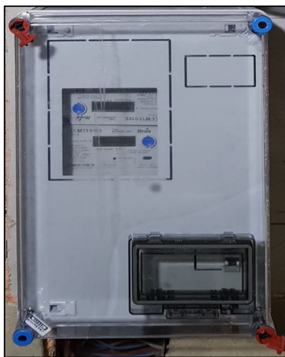
7. ábra Hensel szekrény feltéve a fali fülkében
