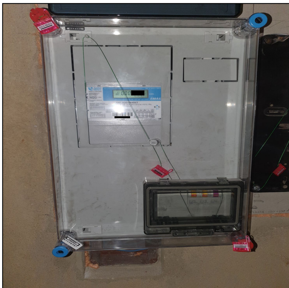
14. ábra Kész fogyasztásmérő zárópecséttekkel
