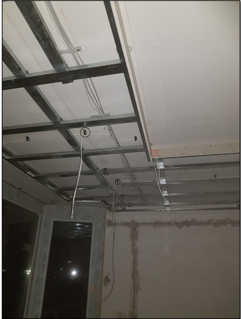
30. ábra Spotok helyei, vezetékei és hangulatvilágítás vezetékei
