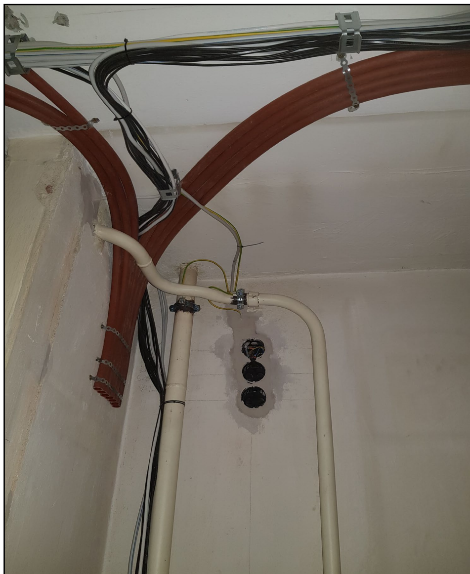
29. ábra Informatikai és televíziós rendszer becsövezése, cső rögzítése hilti szalaggal
