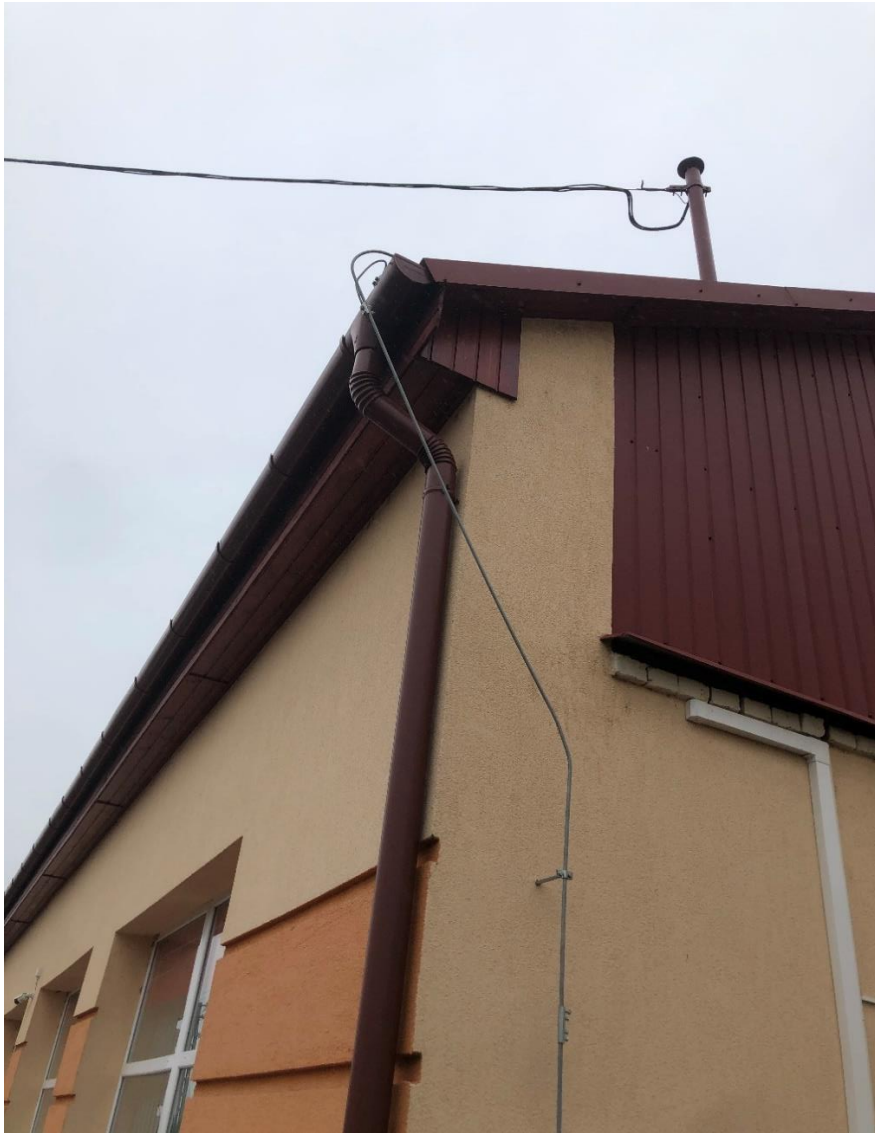
3. ábra A bolt villamos csatlakozása [14]
