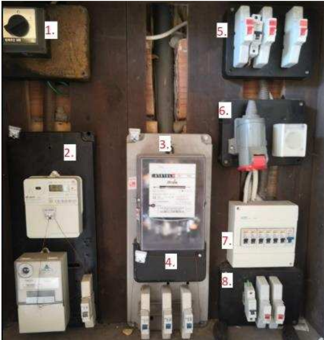
3. ábra: Villamos fogyasztásmérő és lakáselosztók (saját ábra)
