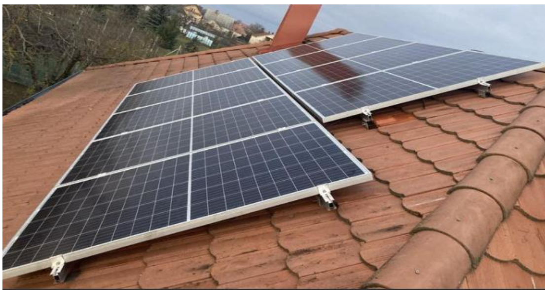
4.3.2 kép: tetőre szerelhető napelempanel tartószerkezete
