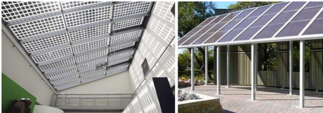
7. ábra Napelemes tetőfedés [17]
