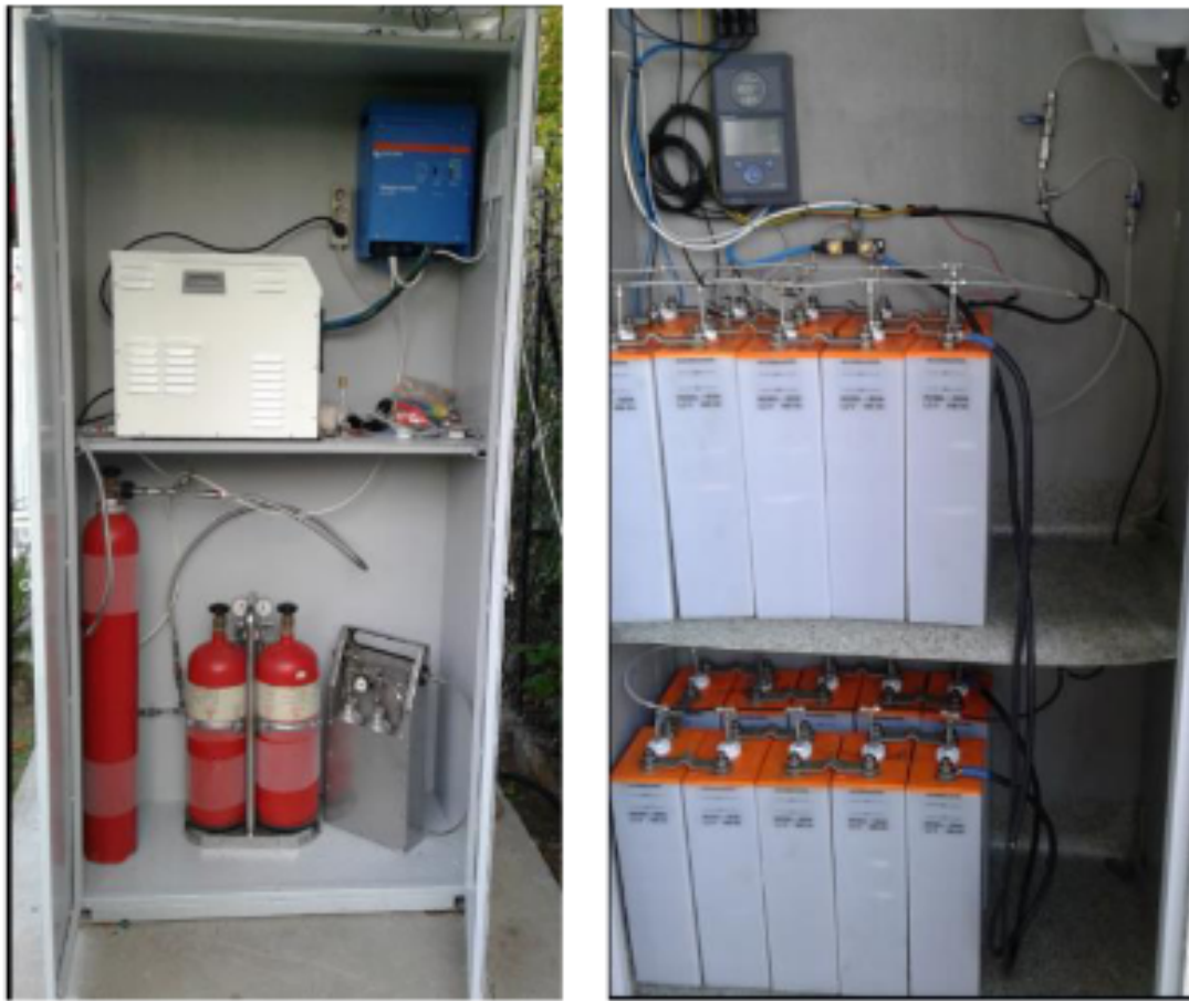
8.7. ábra. A REBOX „szekrényének” gáz-és villamos-oldaliberendezései [33]
