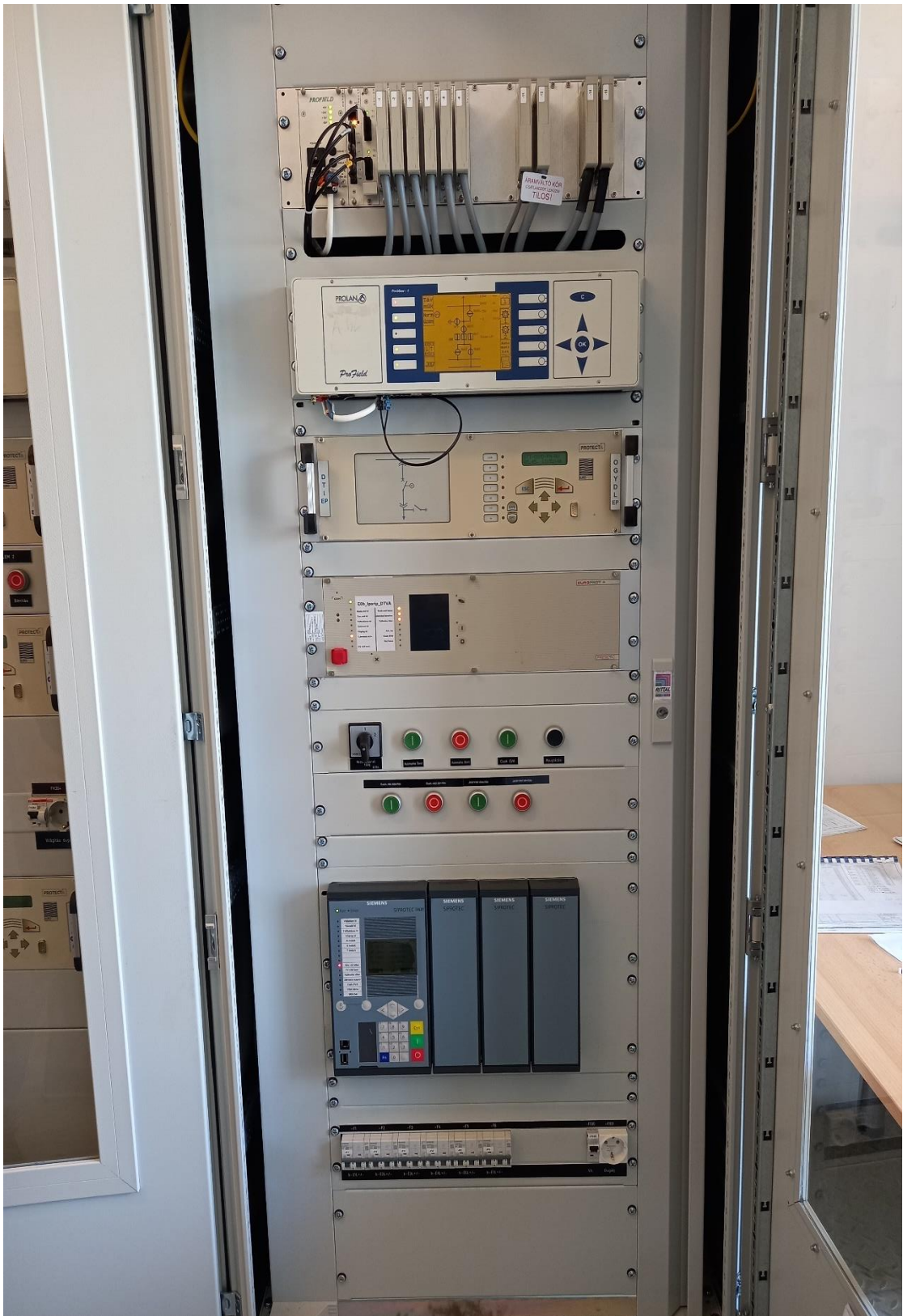
11. ábra 120 kV-os leágazás védelmi szekrénye
