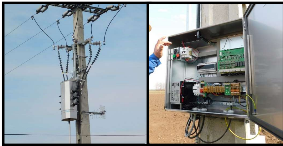
4.2. ábra Távműködtetésű oszlopkapcsoló és vezérlőszekrénye [33]
