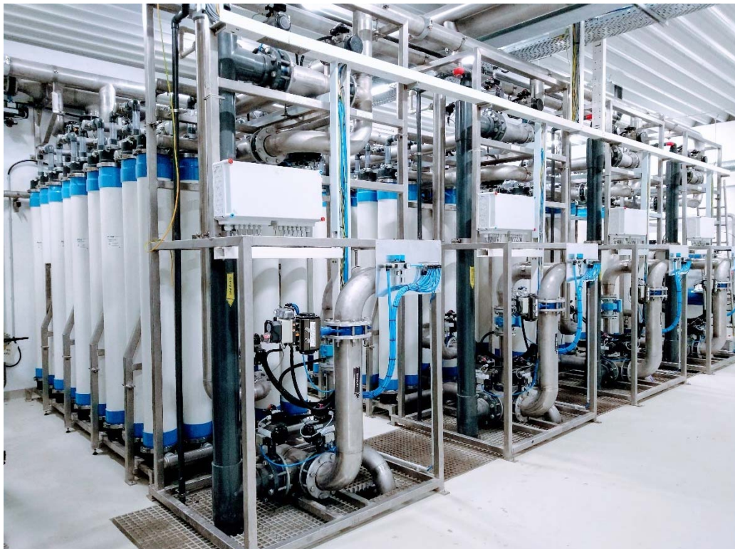
2. ábra: Harmadik tisztítási fokozat - 400 m 3 /h kapacitású ultraszűrő fokozat
