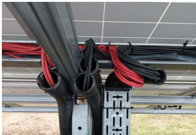
22. ábra: Solar kábelek rögzítése
