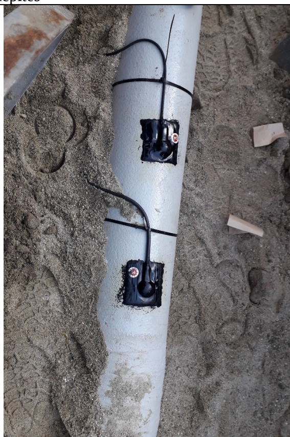
Katódvédelmi csatlakozások
