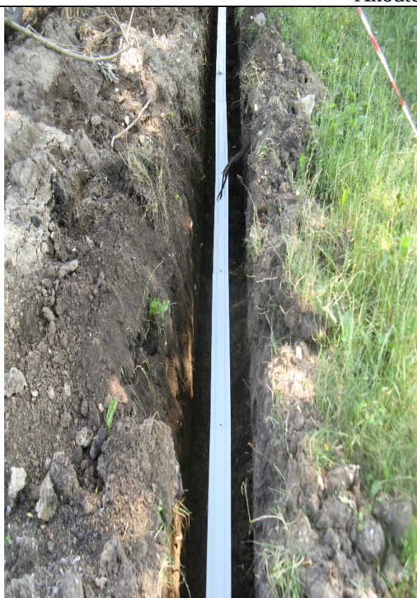
Kábelfektetés
